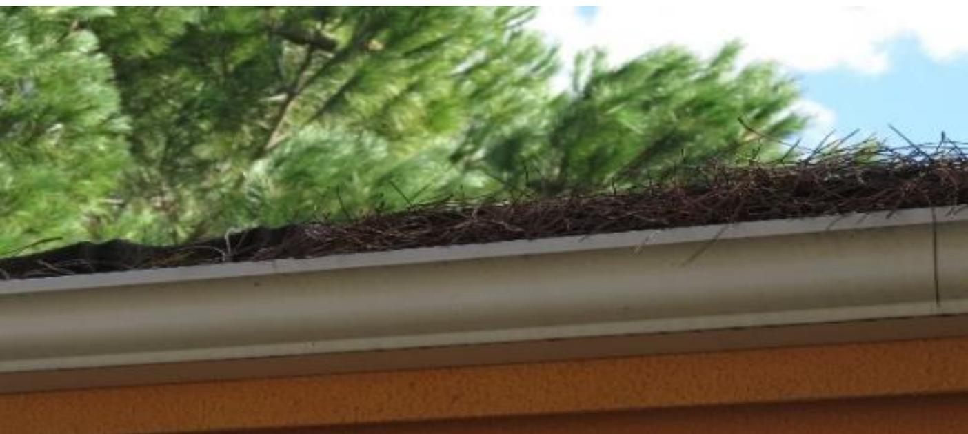
Imagen 28. Canaleta de obra abierta. La caída de material incandescente (pavesas) sobre esta acumulación de hojarasca puede transmitir el fuego al tejado. Es tan importante la calidad y tipología de materiales, como el trabajo de mantenimiento que requiere un jardín. Fuente: MEDI XXI.
