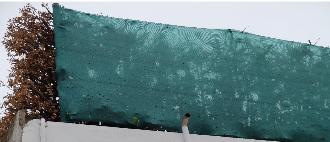
Imagen 72. Detalle de cómo la malla plástica ha actuado de pantalla receptora de pavesas, apreciándose los agujeros en la misma. La vegetación posterior a la malla no se consideró suficientemente opaca y se optó por esta combinación tan peligrosa. Fuente: MEDI XXI.
