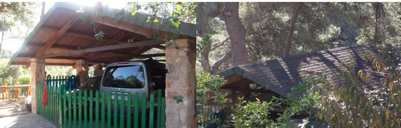
Imagen 56. Cochera fabricada con madera y plástico bajo pinada y cubierta de acículas muertas.
