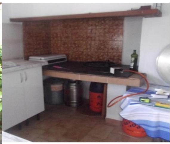
Imagen 53. Bombona refugiada en el interior de la vivienda. Bombona parcialmente refugiada con portón de madera combustible. Fuente: MEDI XXI.
