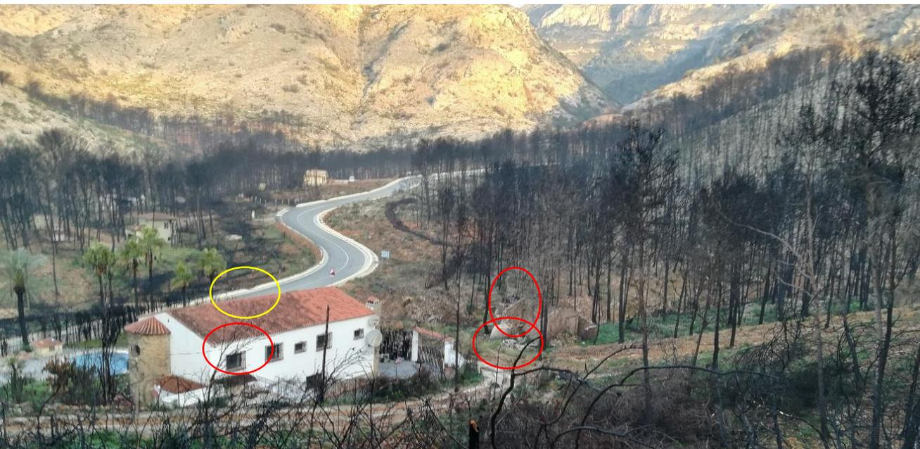
Imagen 64. Se observa que el material de construcción empleado en la vivienda resiste alta intensidad de fuego y la afectación parcelaria se resume a la quema del vallado vegetal de ciprés, pese a las discontinuidades con la masa forestal existentes (vías de comunicación). Se observa como las palmas secas acumuladas por falta de poda en las palmeras se han quemado, permaneciendo la parte viva en el paisaje. Fuente: MEDI XXI.
