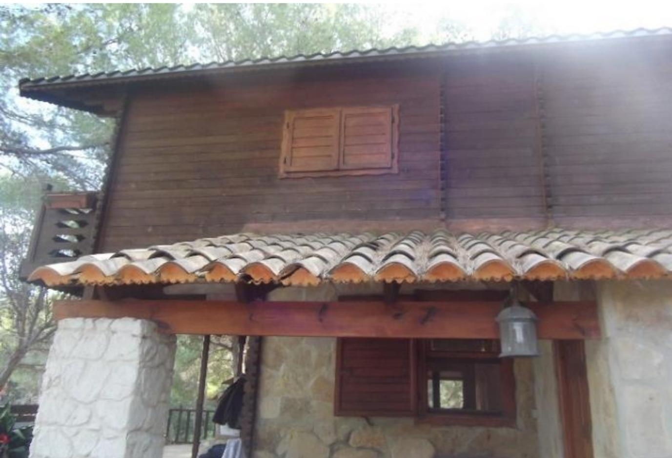
Imagen 30. Combinación de revestimiento de piedra, muy resistente, con láminas de madera muy combustible., en un entorno eminentemente forestal. Fuente: MEDI XXI.
