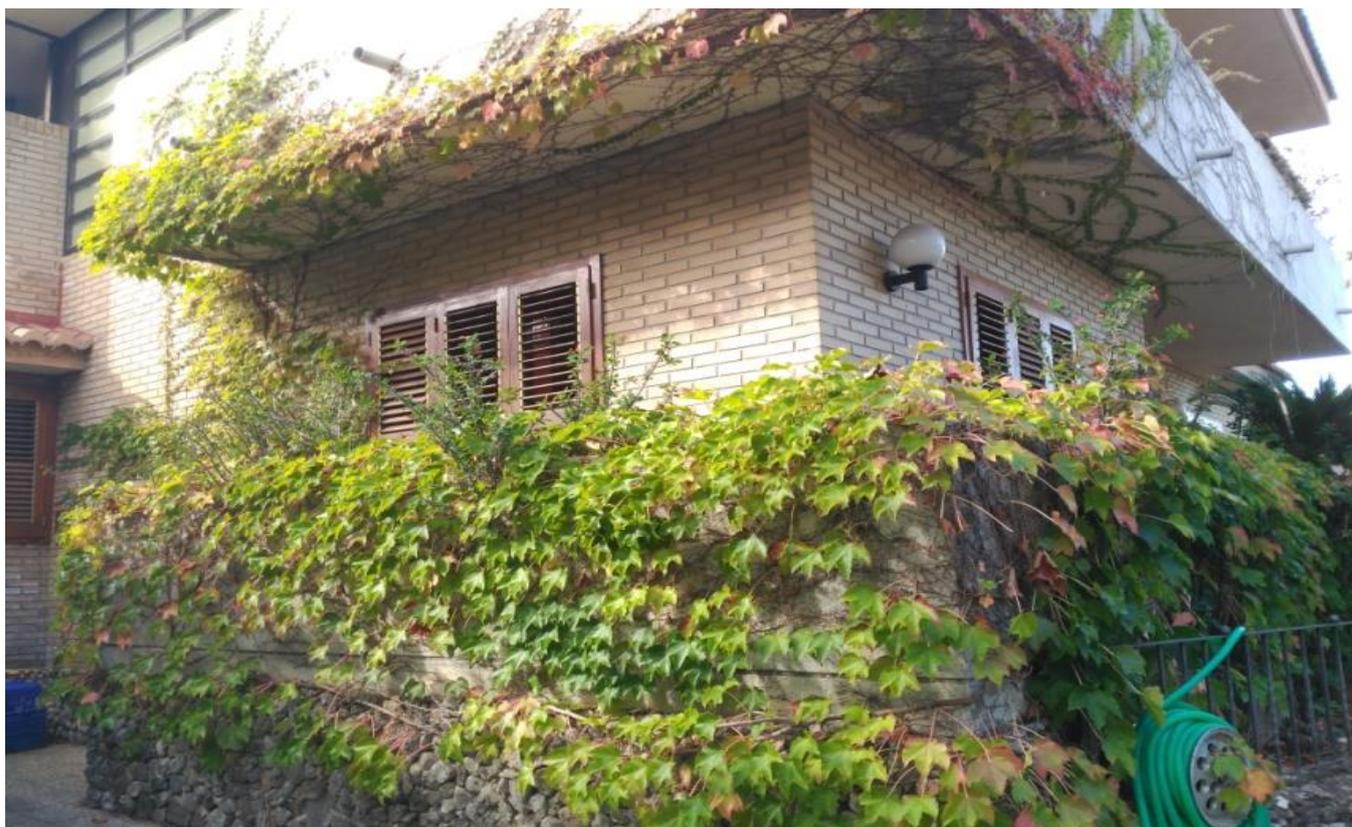
Imagen 47. Recubrimiento de fachada por trepadora. Fuente: MEDI XXI.
