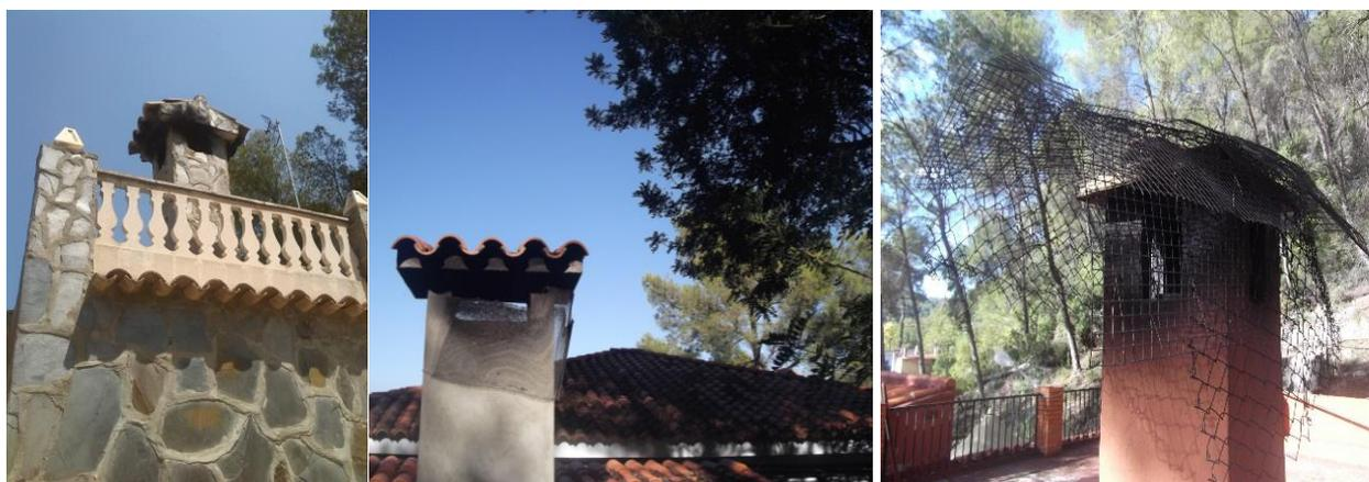
Imagen 57. Salidas de humos incorrectas. Sin rejilla matachispas. Con rejilla mal colocada y luz de malla amplia. Fuente: MEDI XXI.
