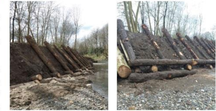
Estabilización de la base del talud mediante entramado de madera tipo kreiner. Colocación longitudinal de troncos
