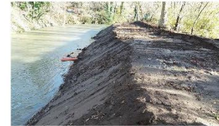
Eliminación del arbolado
