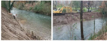
Trenzado de mimbre como base para protección de la estera de ramaje Recubrimiento con tierra vegetal
