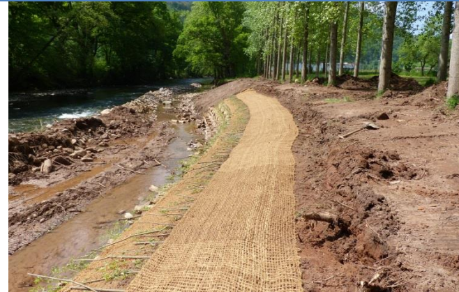
ARRAIOZ. Unión cobertura-entramado. Inserción entramado en terreno
