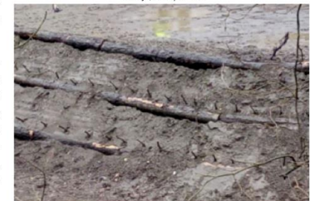
Arriba, vista frontal del enrejado vivo. Debajo, estaquillado
