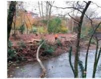
Eliminación del arbolado
