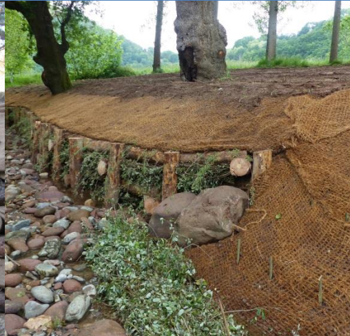
ARRAIOZ. Unión cobertura-entramado. Inserción entramado en terreno
