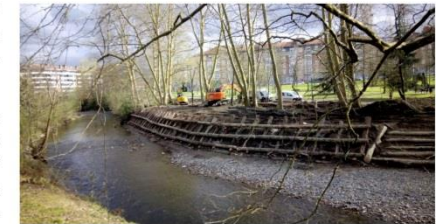
Arriba, vista frontal del enrejado vivo. Debajo, estaquillado
