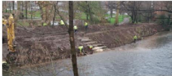
Trenzado de mimbre como base para protección de la estera de ramaje Recubrimiento con tierra vegetal
