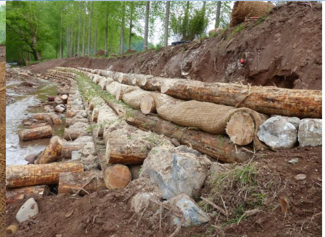
ARRAIOZ. Unión cobertura-entramado. Inserción entramado en terreno
