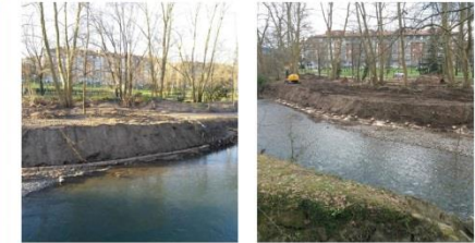
Estabilización de la base del talud mediante entramado de madera tipo kreiner. Colocación longitudinal de troncos
