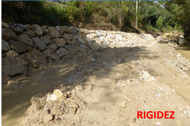
ACEDO. Escollera protección carretera
