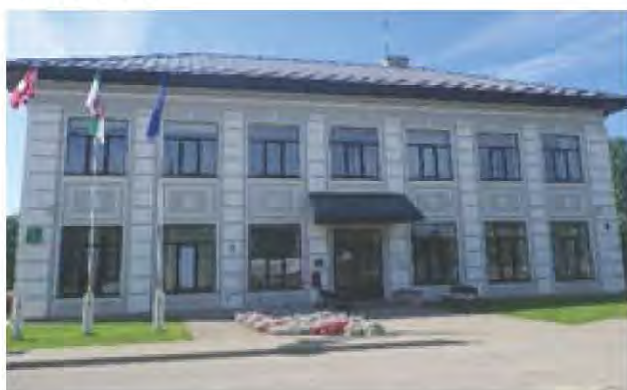
2.20. ATTĒLS: Pašvaldības ēka ar augstu īpatnējo siltumenerģijas patēriņu - Aknīstes novada dome (208 kWh/m²)
