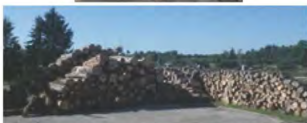
2.11. ATTĒLS: Apkures katls un novietotā malka Asares pamatskolā
