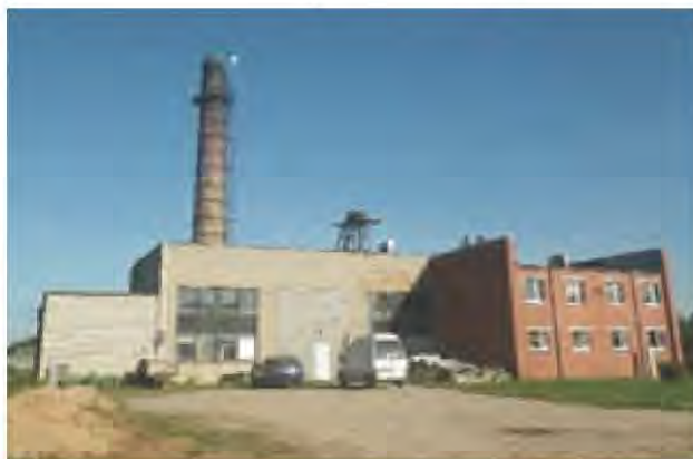
2.6. ATTĒLS: Katlu māja Saltupes ielā 9, Aknīstē
