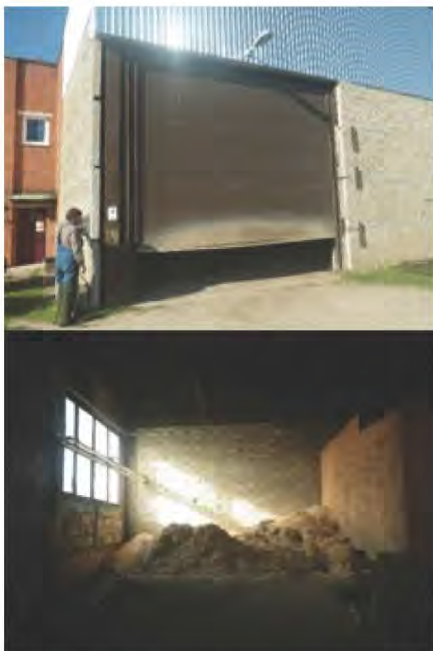
2.8. ATTĒLS: Šķeldas novietne katlu mājā Saltupes ielā 9, Aknīstē
