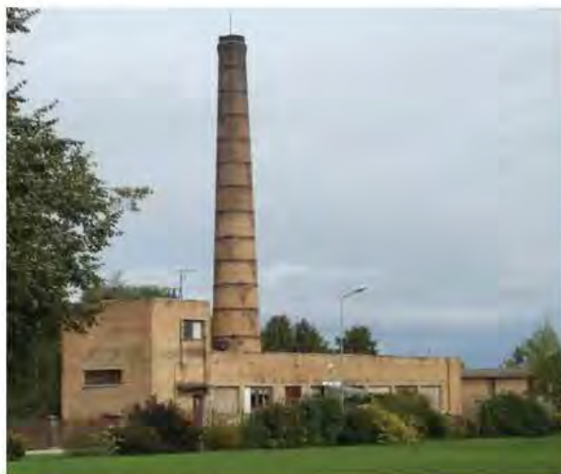
2.9. ATTĒLS: Krimūnu katlu māja. Foto uzņemts apsekojuma laikā (19.09.2017)
