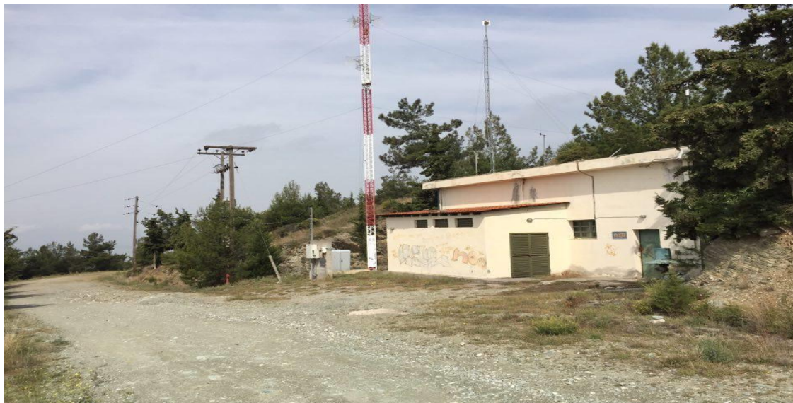
Εικόνα 9. Αντλιοστάσιο στον δρόμο «Χίλια Δέντρα-Εξοχή»
