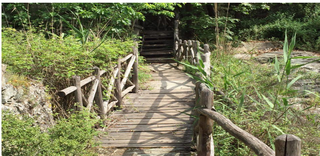
Εικόνα 4. Μονοπάτι διαμορφωμένο με ξυλοκατασκευή στη θέση Κρυονέρι Πηγή: Διαχειριστική μελέτη Περιαστικού δάσους Θεσσαλονίκης για τα έτη 2019-2028
