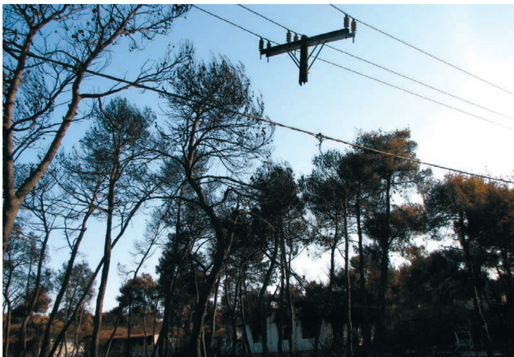
Изображение 6 : Част от решетката на електрическата мрежа е окачена от кабелите, а останалата част е изгорена и паднала на земята.
