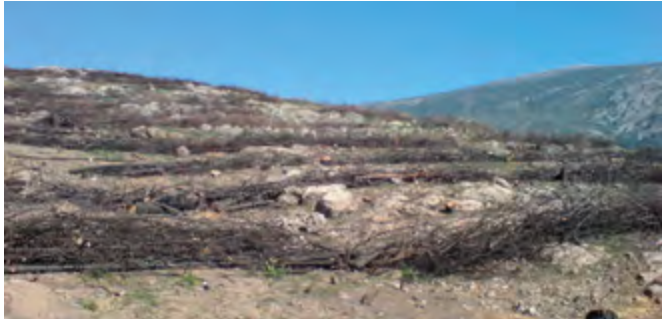
Εικόνα 12. Κατασκευή κλαδοδεμάτων στην περιοχή του Καρέα στην Αττική το 2008 (πηγή : http://george1961.blogspot.gr/2008/04/blog-post.html )
