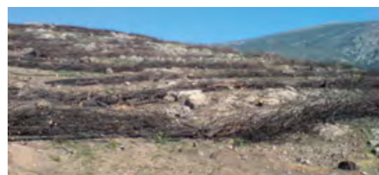
Εικόνα 9: Κατασκευή κλαδοδεμάτων στην περιοχή του Καρέα στην Αττική το 2008 (πηγή : http://george1961.blogspot.gr/2008/04/blog-post.html )
