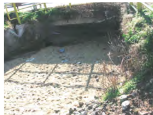
Εικόνα 4: Πρόσχωση πεδινών αντιπλημμυρικών έργων από φερτά υλικά (Πηγή: Στεφανίδης Π., 2016. Διευθετήσεις Ορεινών Υδάτων II. Πανεπιστημιακές Παραδόσεις, Τμήμα Δασολογίας και Φυσικού Περιβάλλοντος, σελ. 244.
