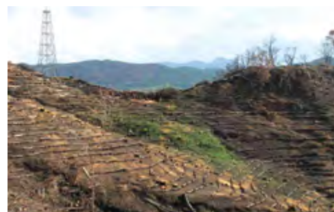
Εικόνα 8: Κορμοδέματα που κατασκευάστηκαν στην περιοχή της Αρχαίας Ολυμπίας μετά την πυρκαγιά της 26ης Αυγούστου 2007 (πηγή : http://library.tee.gr/digital/m2291/m2291_baloutsos.pdf )
