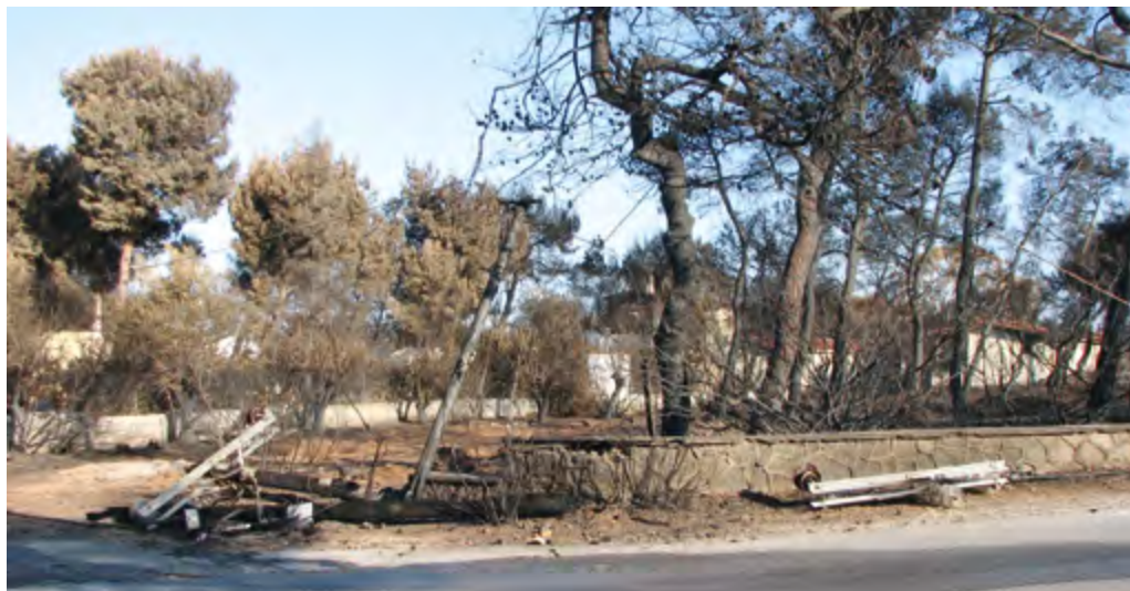
Εικόνα 5: Τμήμα του δικτύου ηλεκτροδότησης έχει καταστραφεί από δασική πυρκαγιά
