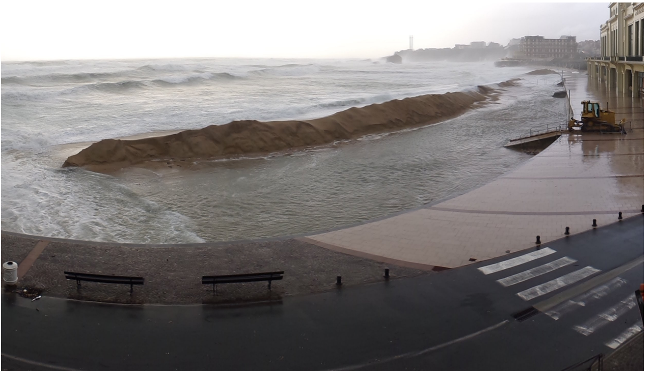
Figure : ouvrage temporaire de protection mis en place durant la tempête Christine
