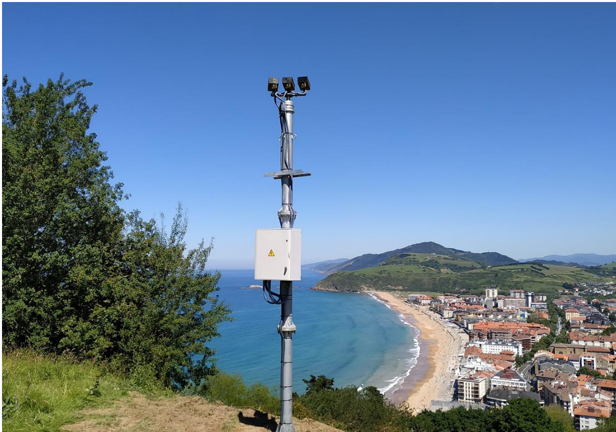
Vista del nuevo poste y equipos de la estación de videometría de Zarautz
