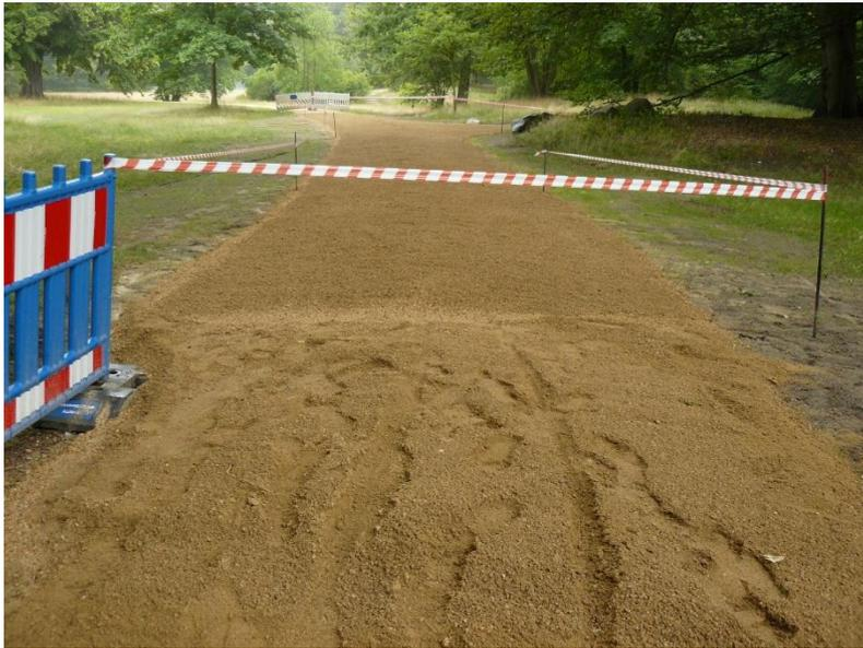
Diese Fläche musste auf der gesamten Strecke neu profiliert werden, nachdem respektlose, unachtsame Fahrradfahrer und Fußgänger die frisch eingebrachte Deckschicht beschädigt hatten.
