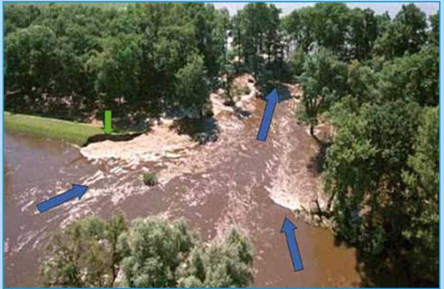
Abb. 17: Deichbruch beim Hochwasser der Oder im Jahr 1997. Der grüne Pfeil markiert den Deich. Die blauen Pfeile zeigen an, wie das Wasser durch die Bruchstelle hindurchfließt.
