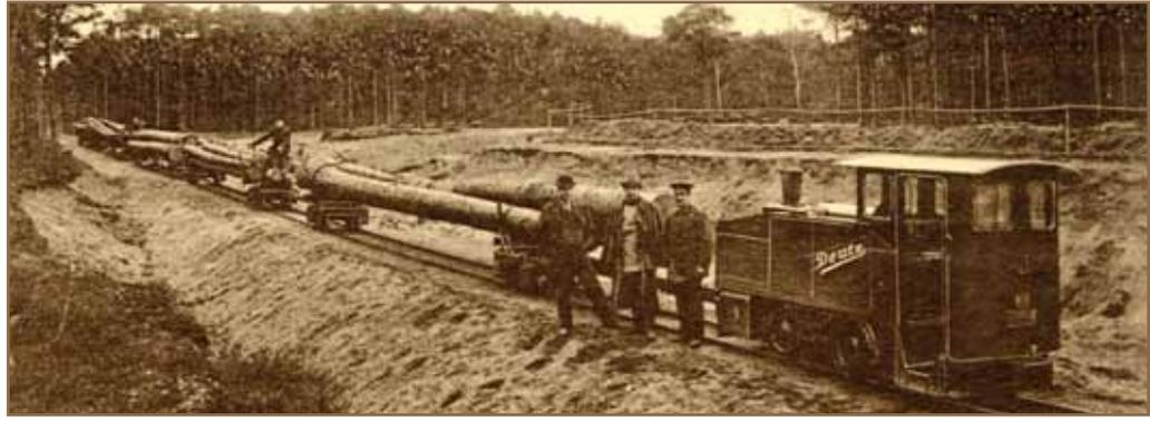
Abb. 60: Langholzzug mit einer 12-PS-starken Benzollokomotive der Fa. Deutz auf der Strecke bei Neudorf. Um 1914.
