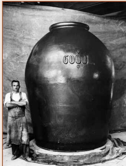
Abb. 48: Der größte, in den Deutschen Ton- und Steinzeugwerken AG, Werk Krauschwitz, hergestellte Steinzeugbehälter, Fassungsvermögen 6000 Liter, um 1925.
