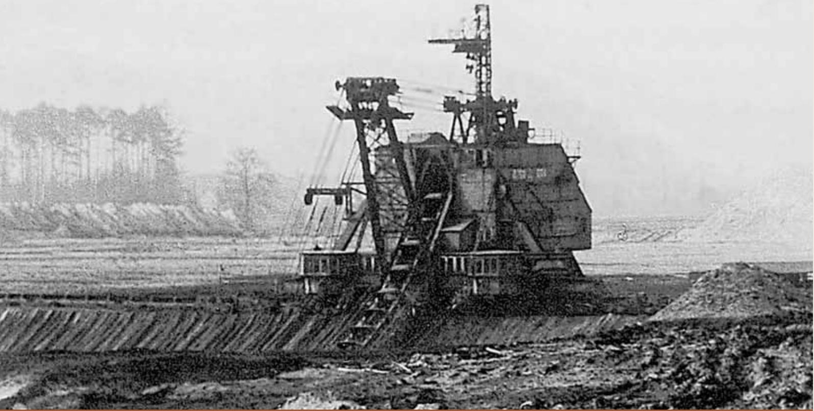
Abb. 40: Im Tagebau „Frieden“ bei Halbendorf erfolgte die Förderung von Braunkohle mit kleinen Eimerkettenbaggern. Das Foto stammt etwa aus dem Jahr 1963.
