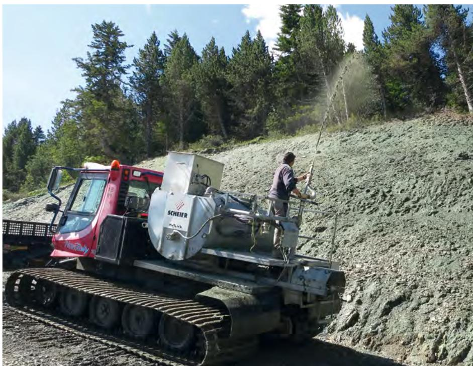
Fig. 66 – Siembra con hidrosebradora
