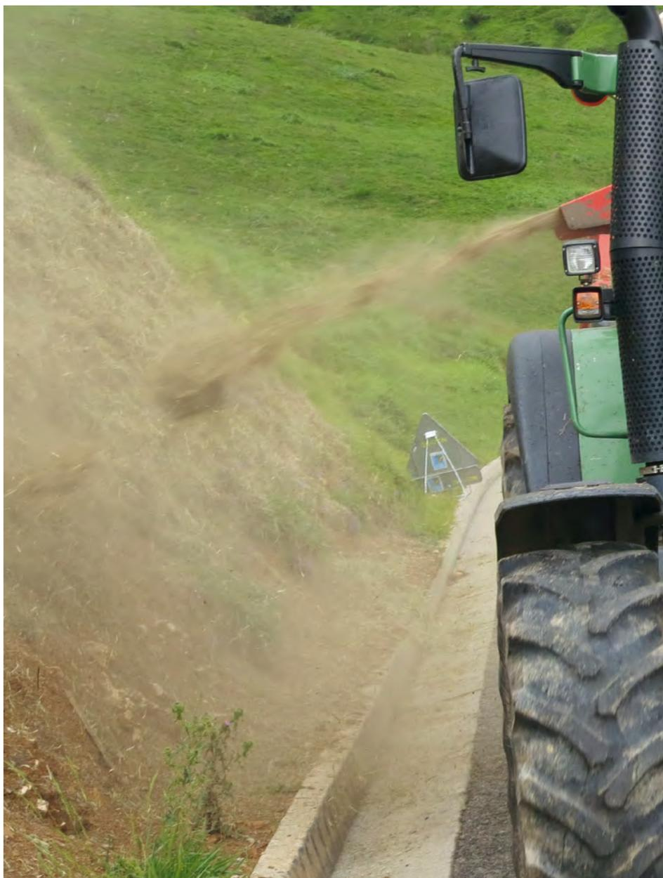
Fig. 64 – Máquina empajadora empleada para la siembra de un talud de carretera con siega recién cortada
