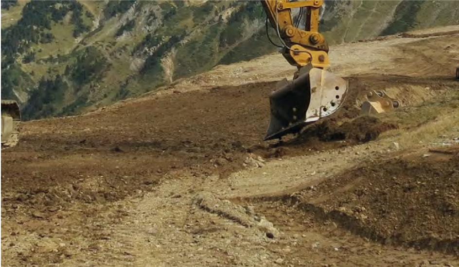
Fig. 17 – Extendido de una capa de tierra vegetal antes de la siembra
