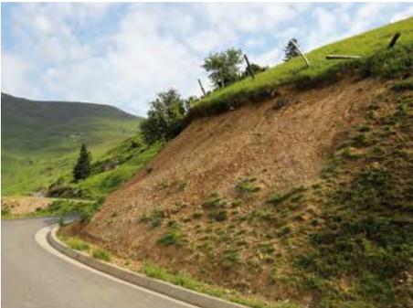
Fig. 61 – Efecto del empleo de una malla sobre la implantación de una siembra. Sobre la parte derecha del talud, la colocación de una malla de yute ha favorecido el desarrollo y la fijación de las especies sembradas.
