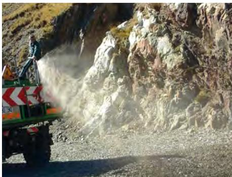
**Fig. 68a** – Siembra de 125 kg/ha de una mezcla de semillas locales recolectadas con cepilladora [Supebagnères, 06/10/17]. El objetivo era evaluar los rendimientos de las semillas locales sobre sustratos degradados por antiguos movimientos de tierra.
