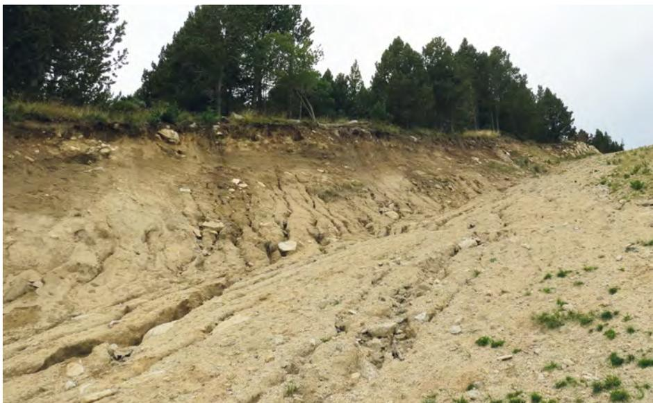
**Fig. 15 – Talud y pista de esquí muy degradada por la erosión hídrica**
