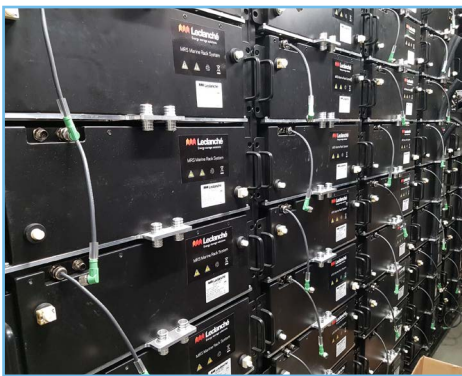
Abb. 12 Batterie Speicher aus Li-Ion Batterien.
