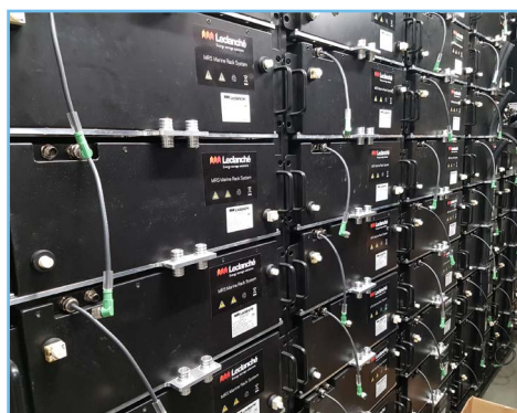
Fig. 12 Li-Ion batterielager.
