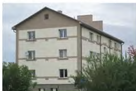
2.22. ATTĒLS: Atjaunota (siltināta) daudzdzīvokļu ēka Kūku ciemā
