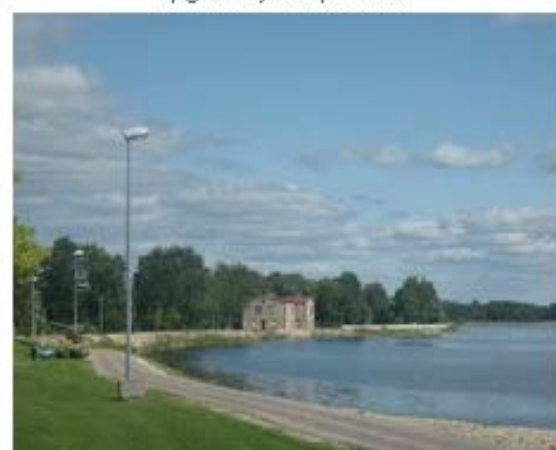
2.26. ATTĒLS: Publiskais apgaismojums uz Pļaviņu dambja
