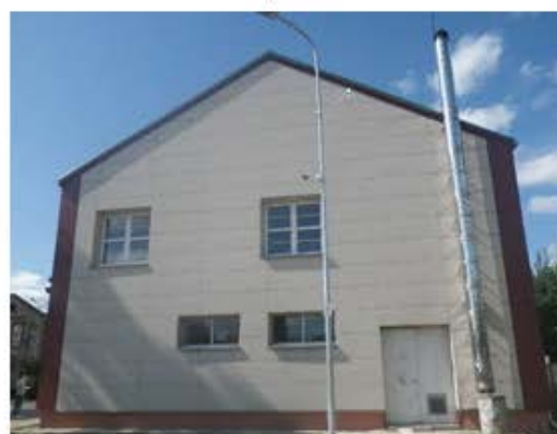
2.12. ATTĒLS: Vietēja granulū katlu māja Daugavas ielā 50
