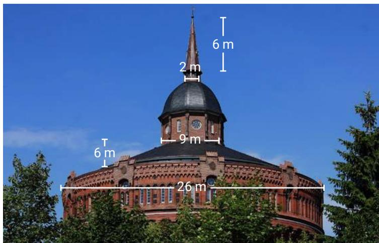
Einige Hausdächer werden mit Kupferblech bedeckt. Kupfer ist recht beständig und erfordert entsprechend wenig Wartung. Außerdem lassen sich Dächer und Fassaden mit komplizierten Geometrien damit gut eindecken. Im Laufe der Zeit ändert sich die Farbe der Dächer von der eigentlich rot-goldenen Farbe durch Einfluss von Feuchtigkeit und Sauerstoff zu ihrer typischen grünen Farbe.
