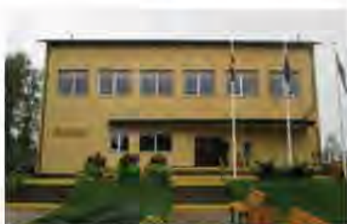
2.20. ATTĒLS: Pašvaldības ēka ar zemu īpatnējo siltumenerģijas patēriņu – atjaunotā Sēlpils pagasta pārvaldes un kultūras nama ēka (85 kWh/m²)
