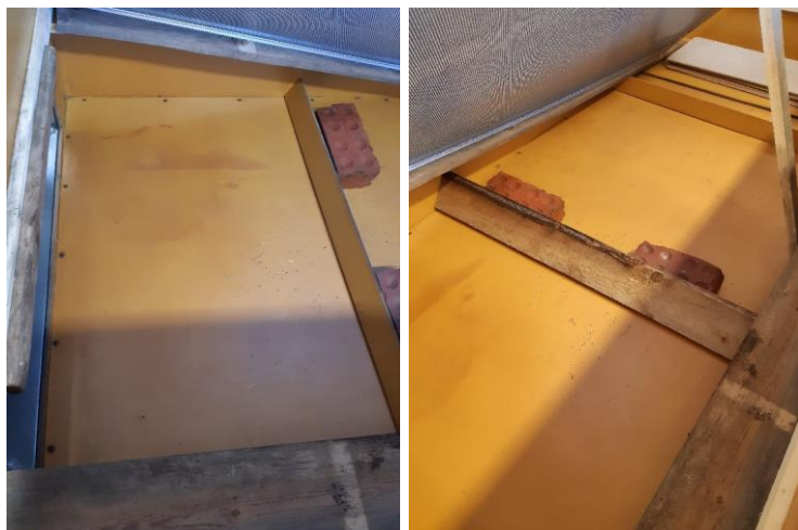
Fig. 10 och 11. Vänstra bilden visar den smala fanerskivan ungefär 80 cm från luftöppningen. I höger två hinder, 15 cm bräda främst och den smalare fanerskivan c. 150 cm från luftöppningen. I bilderna syns också den perforerade plåtskivan snett i kanalen.
