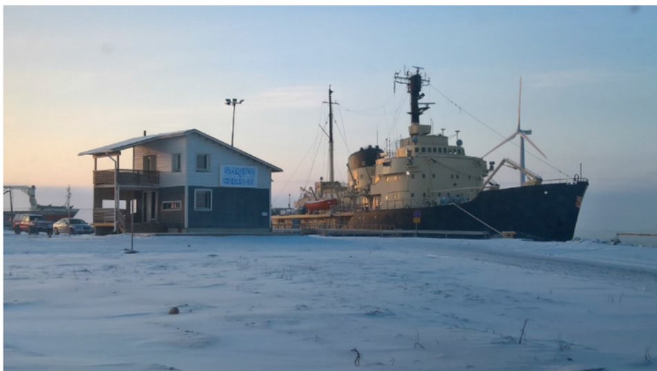
Kuva 1. CLT-Koetalo siirrettiin alkuperäiseltä rakennuspaikaltaan Kemin Digipoliksestä kokonaisuena Ajoksen satamaan lokakuussa 2015. Talo on vuokrattu Kemin Matkailu Oy:lle jäänmurtaja Sammon risteilymatkustajien Check in tilaksi. Talvisesongin aikana 2015-2016 Kemissä vierailee n. 18 000 matkailijaa. (Kuva Kimmo Heikka)
