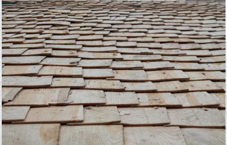
1926 kokouksessa: ”Katon tulee lyötä 4 ½ tuuman nostolla syrjän päälle, 2 ¼ nauloilla ¼ suunile vahvoilla pärheillä.” (Kuva: Jarno Niskala)
