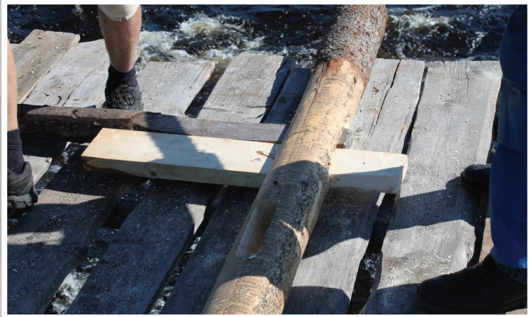
Kuva: Kurkkuvaaja lyöty paikoilleen jalkapuun viereen (JN).
