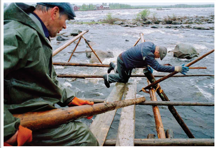
Kuva: Vaajoja eli vittajalkoja asetetaan vaulun läpi. Kuvaaja Jaakko Heikkilä.
