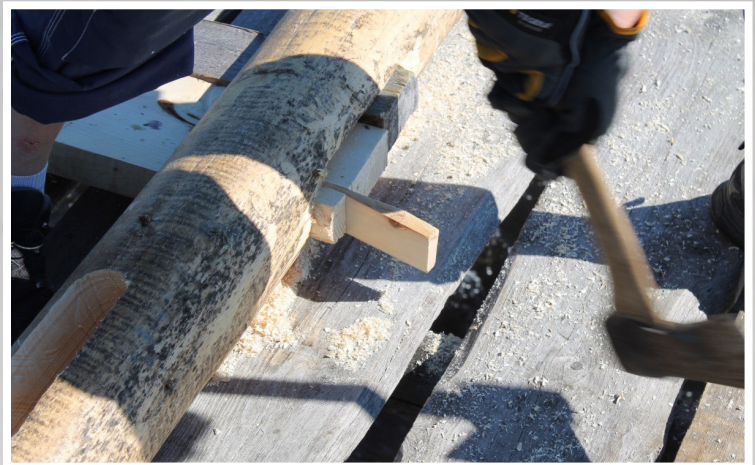
Kuva: Pienelle kiilalle tehdään aloitusviihto kirveellä (JN).
