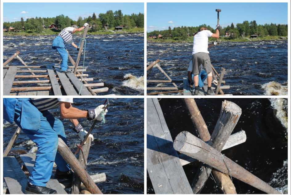
Kuva: Vaajojen eli vittajalkojen kiinnittäminen. Vittajalat lyödään tukevasti pohjaan. Kiristämiseen voidaan käyttää vänkäriä (JN).
