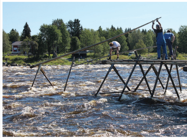
Kuva: Heittoa asetellaan selkäpuun alle (JN).
