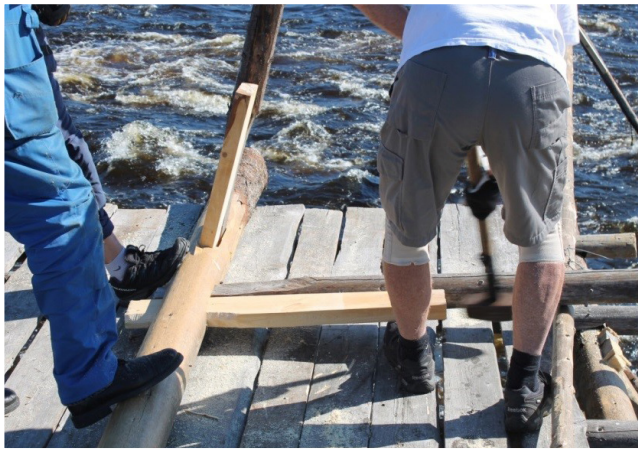
Kuva: Jalat ja kiilat haara-asennossa (JN).
