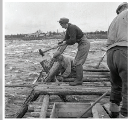
Kuva: Lohipadon vaajoitusta. Kukkola 1949. Roll foto, Haparanda Stad.
