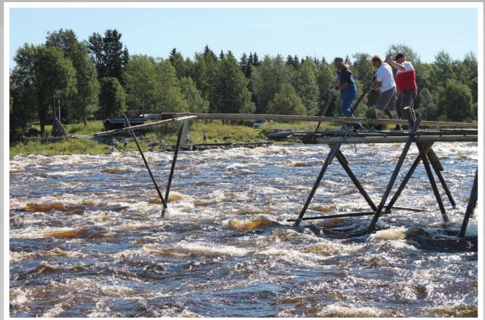
Kuva: Selkä kaadetaan pystyasentoon (JN).
