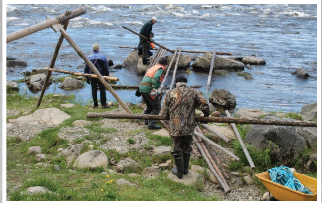
Kuva: Nälkäkiven krenkun lähtö, oikea paikka katsotaan rantakivistä. Lähtöpuu laitetaan rautasinkilön läpi ja toinen pää kiven päälle. (JN).
