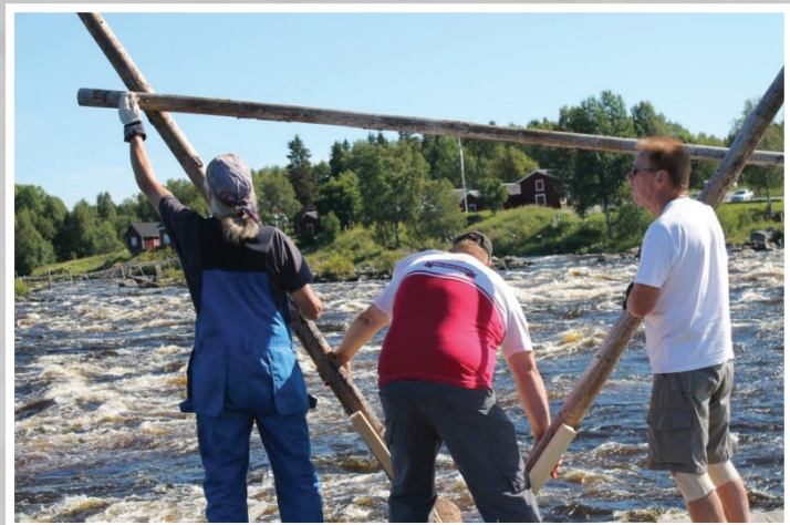
Kuva: Puomipuun kiinnitys (JN).
