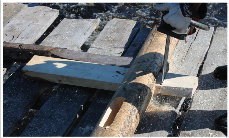
Kuva: Ylimääräinen patkku kurkkuvaajasta katkaistaan (JN).
