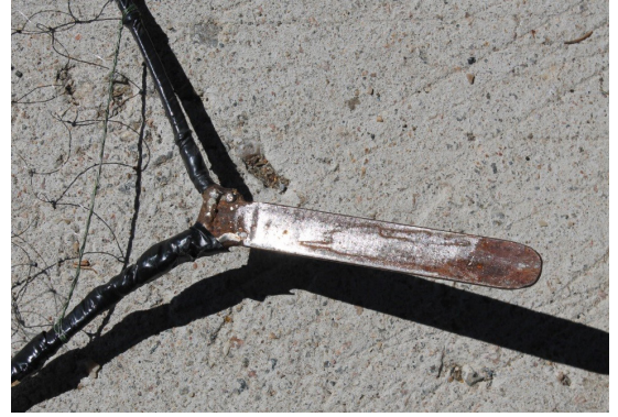
KUVA: Vanhempi metallinen kiinnike. Vuennonkoski (JN).
