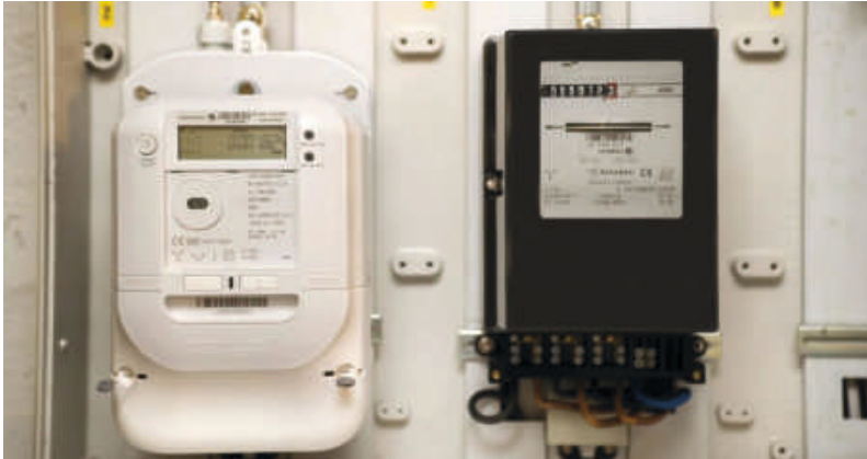
Slimme meter versus elektriciteitsmeter
