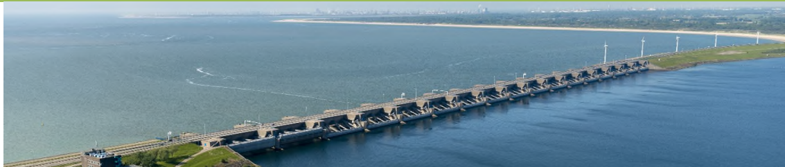
Haringvlietsluices (picture: Rijkswaterstaat)
