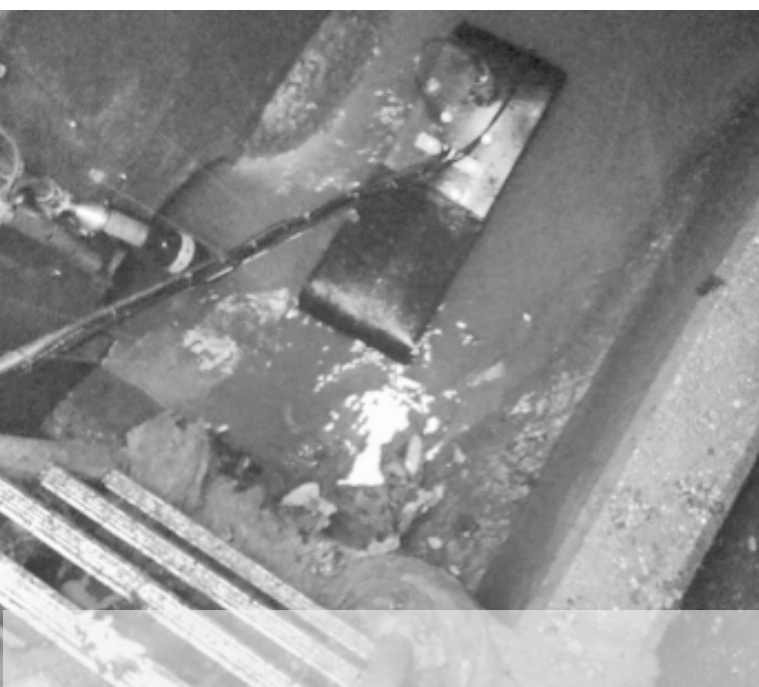
Figuur 5 Vlotconstructie (spectrometer gemonteerd aan onderkant)
