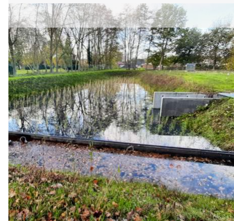
Figuur 27 Zicht op zuiveringsrietveld Fierkens
