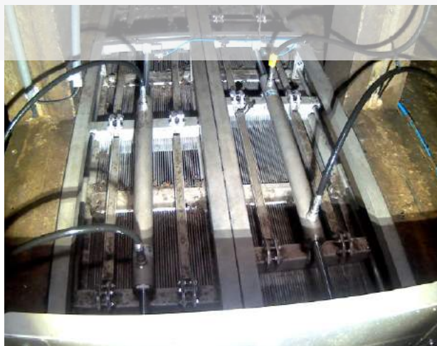
Figuur 28 Automatisch reinigend rooster overstort Kenensdijk
