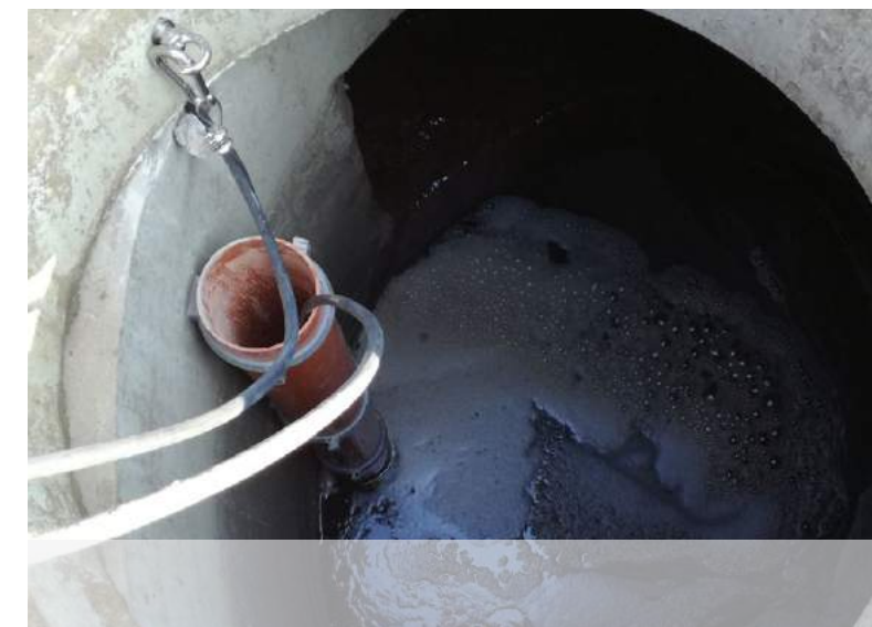
Figuur 34 Geleidebuis multiparametersonde Oudsbergen
