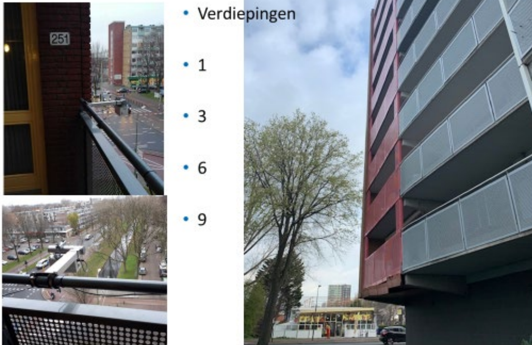
Figuur 6. Impressie van het gebouw en meetapparatuur aan de balkonrand
