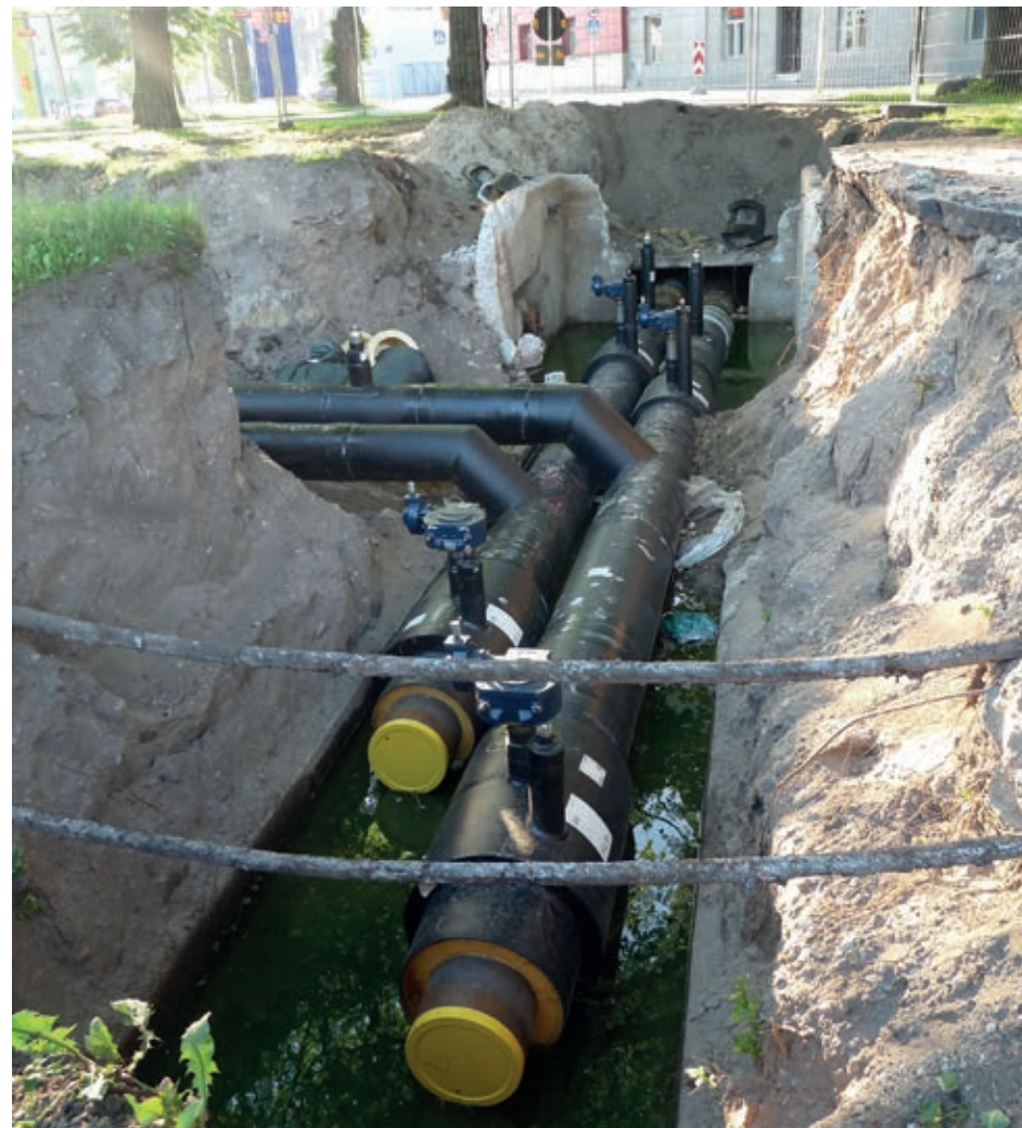
Aanleg leiding warmtenet in Tallinn, Estland (Dmitry G, Wikimedia Commons)
