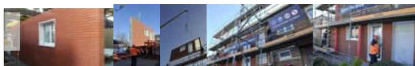
Dix minutes chrono: c'est le temps qu'il a fallu aux quatre compagnons de Rabot-Dutilleul d'installer la nouvelle façade isolante sur le mur de briques d'une maison Villogia, au 46 rue Védrii
