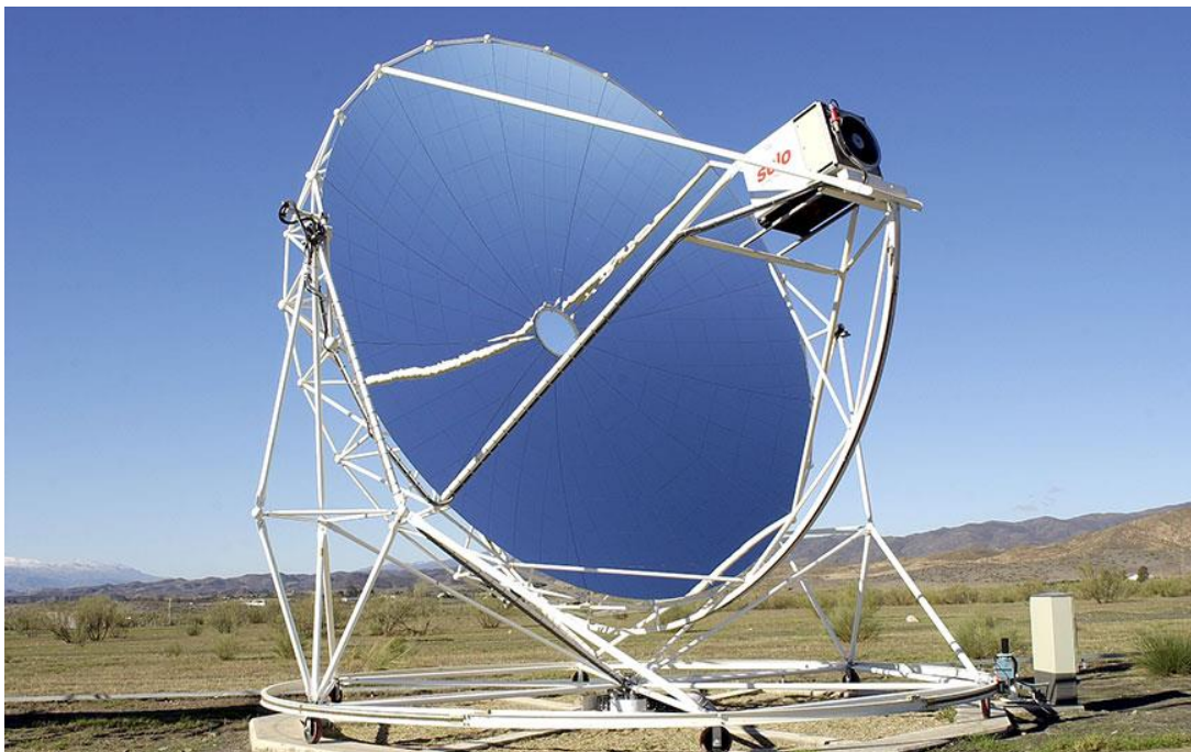
Φωτό 1. Ηλιακό σύστημα με παραβολικό κάτοπτρο και μηχανή Stirling που παράγει ηλεκτρική και θερμική ενέργεια.
