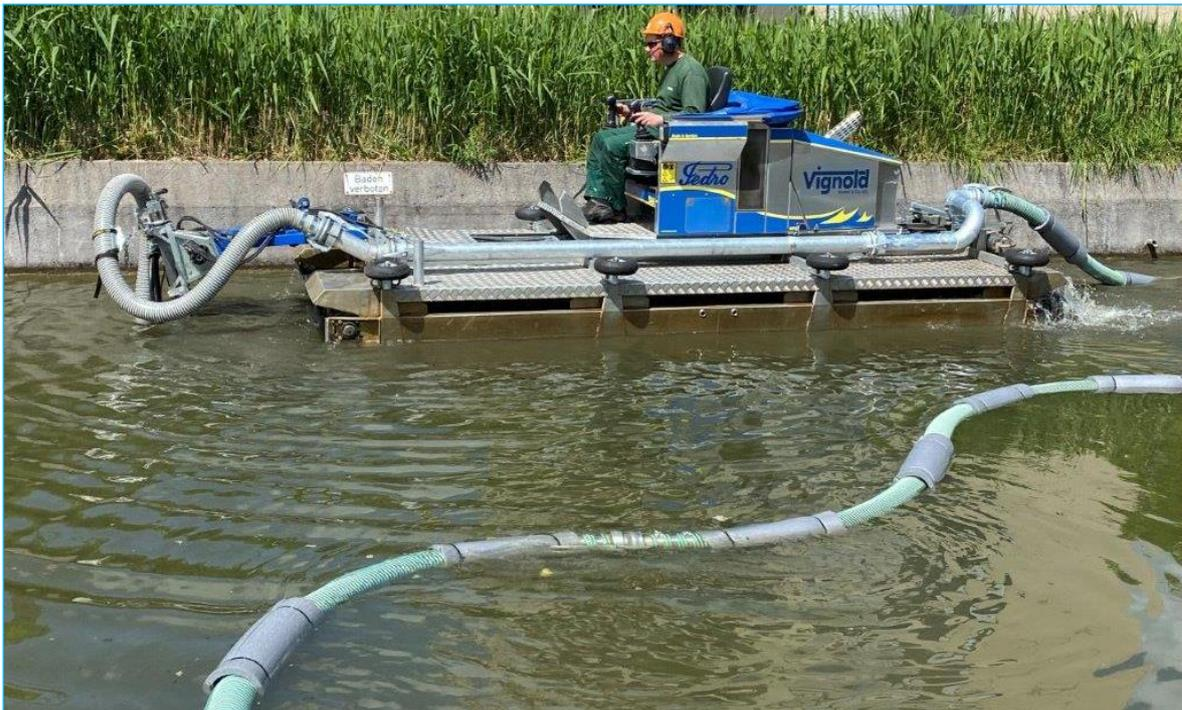
Um einen Langarmhydraulikbagger einsetzen zu können, muss der gesamte Bewuchs im Uferbereich entfernt werden. Der Eingriff in den Vegetationsbestand ist erheblich. Der Einsatz eines Schwimmbaggers erfordert dagegen nur, dass die Zuwegung zum Teich freigelegt werden muss. Im Hinblick auf den Eingriff in Lebensräume hat die Entschlammung mit einem Schwimmbagger also grundsätzlich Vorteile durch die wesentlich geringere Flächeninanspruchnahme.
