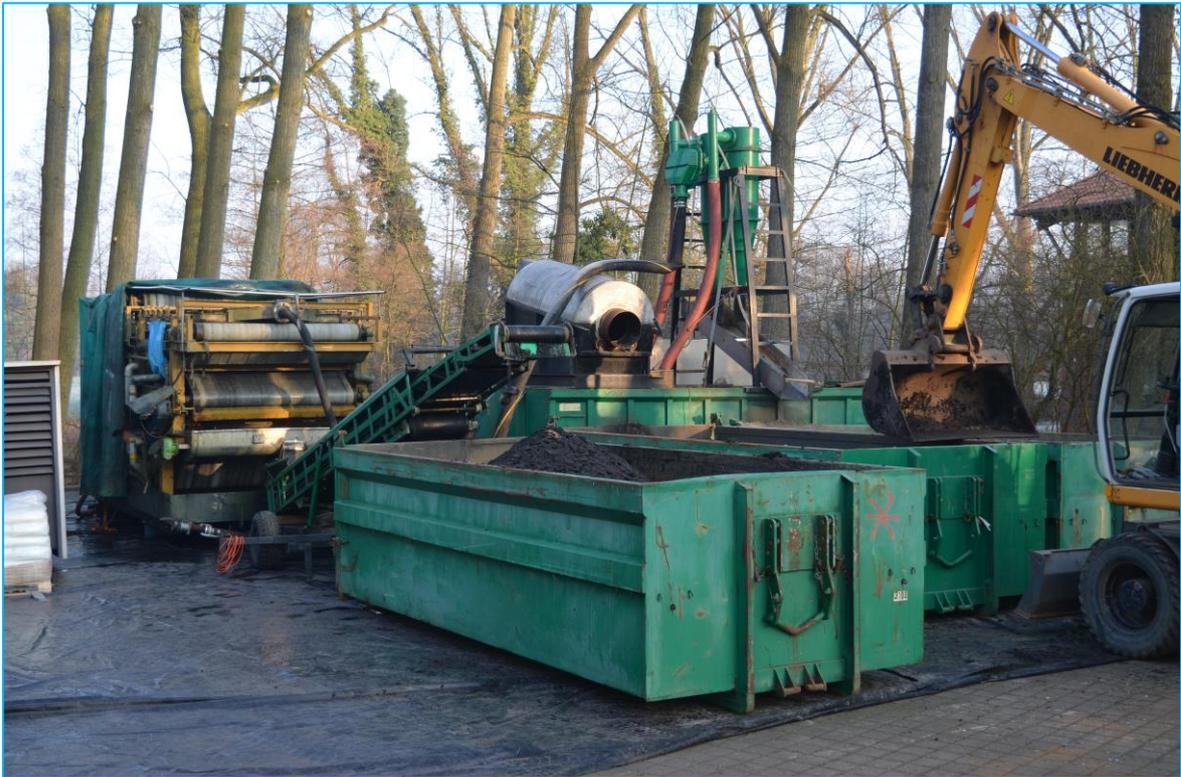
Auch hier bietet der Einsatz eines Schwimmbaggers erhebliche Vorteile. Der Schwimmbagger fördert das gehobene Gut über eine Leitung zu einer Siebbandpresse, die das Material nicht nur entwässert, sondern in mehrere Fraktionen (Sand, Schluff, Grobstoffe) aufteilt, die in eigenen Containern aufgefangen werden (vgl. Abb. 15). Damit ist die bauzeitliche Flächeninanspruchnahme wesentlich geringer, Zwischenlagerzeiten fallen nicht an.
