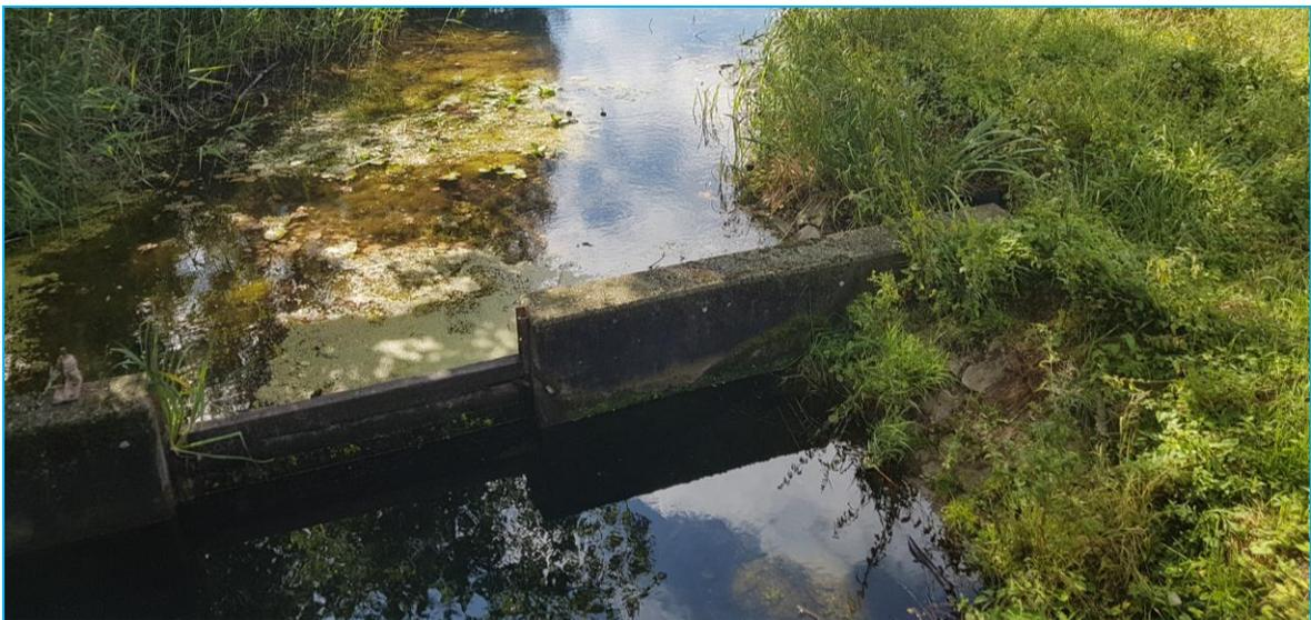
Gleichzeitig könnte die Schwelle am nördlichen Auslauf des Abgrabungsgewässers angepasst werden. Das Querbauwerk besteht aus einem Dammbalkenwehr, das leicht durch Herausnahme eines Balkens in der Höhe verändert werden kann (vgl. Abb. 13). Auch hier ist es möglich, bei negativen Auswirkungen der Maßnahme unmittelbar den ursprünglichen
