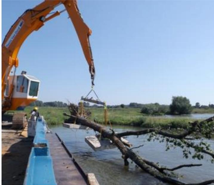
Abb. 10: Absenken der Raubäume mit Lasttraverse.
