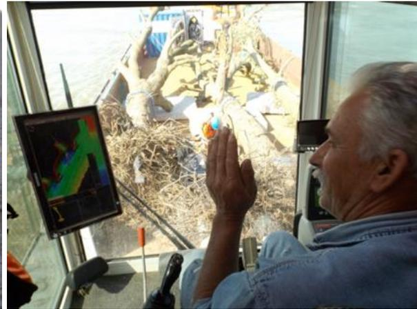
Abb. 9: Das Versenken der Raubäume ist Präzisionsarbeit: Deshalb ist es wichtig, dass der Kranführer vor Ort ein Bild von der Tiefe und der aktuellen Lage des Schiffes und des Baumes hat.
