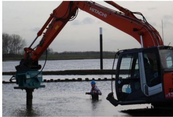
Abb. 4, 5: Einrütteln eines Stahlträgers in einem Bühnenkessel bei Everdingen.
