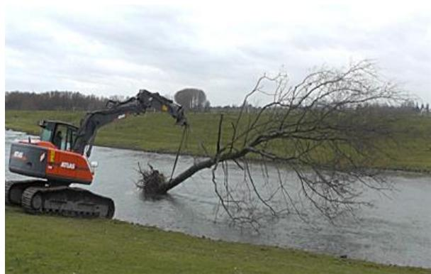
Abb. 6: Stahlkette durch Auge im Raubaum.
