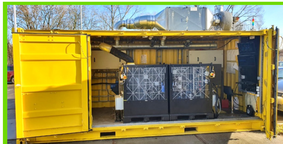
Afbeelding 1: Het Elestor batterijsysteem voorzien van modules met een Gen4 stack
