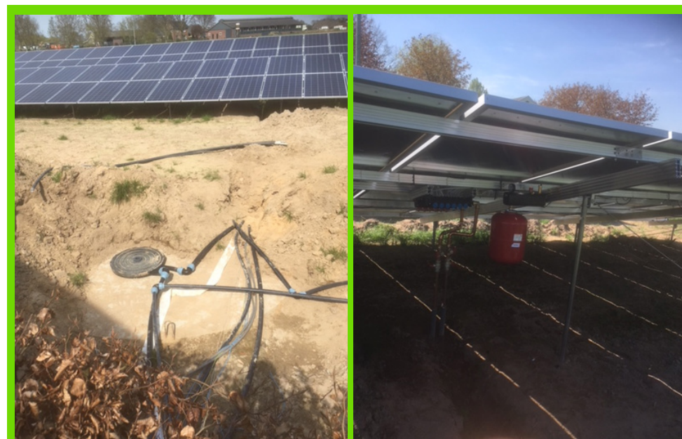
Voorbeeld van hoe de onderdelen in de ondergrond en het knieschot zijn geplaatst.
