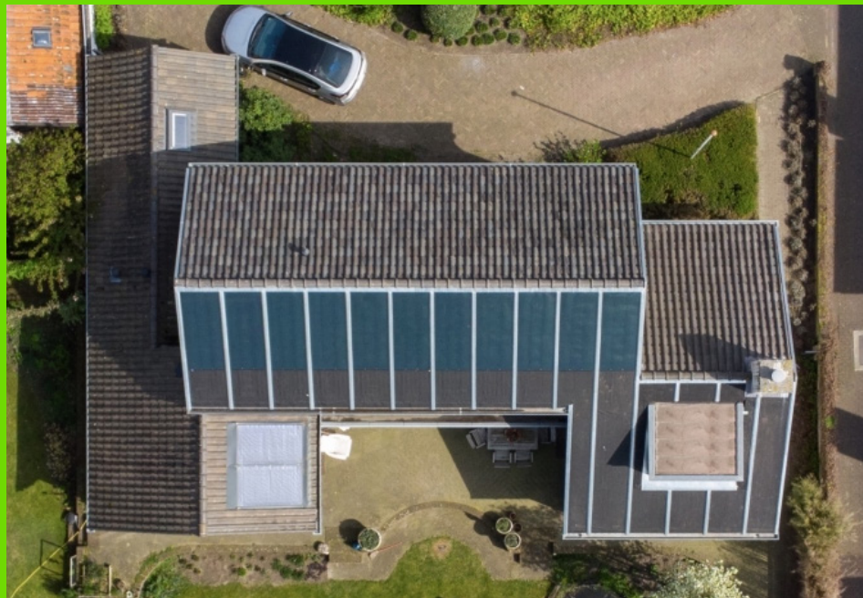
Afbeelding 2: Het tweede gerealiseerde project is een bestaande, matig geïsoleerde woning in Oirschot binnen een beschermd stadsgezicht. De warmte uit het dak wordt voor meerdere doeleinden ingezet: voorverwarming van een warmwater boiler, directe aansturing van een grondgebonden 20 kW warmtepomp en regeneratie van een gesloten bodembronnensysteem. De elektra wordt omgezet om de warmtepomp aan te sturen. De woning is gasloos en voorziet in de eigen energiebehoefte.
