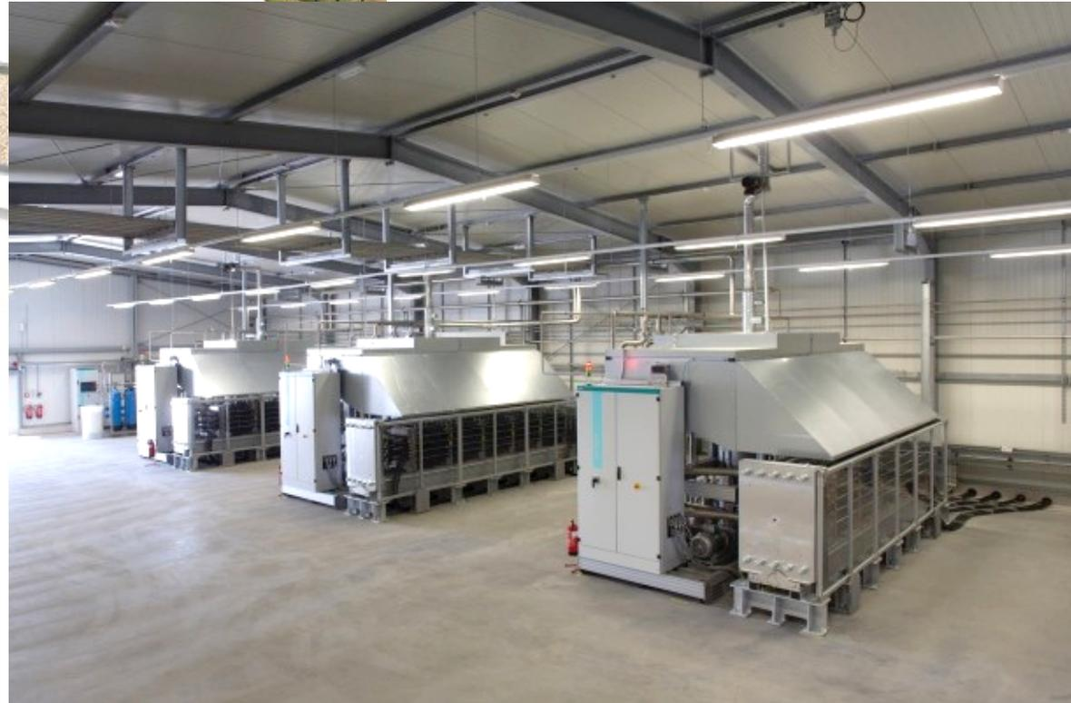
Die Schwankungen im Tagesverlauf und anteilig im Jahresverlauf, insbesondere Sommer-Winter-Betrieb, können u. a. über dezentrale Gasröhrenspeicher (s. Bild) abgedeckt werden.
