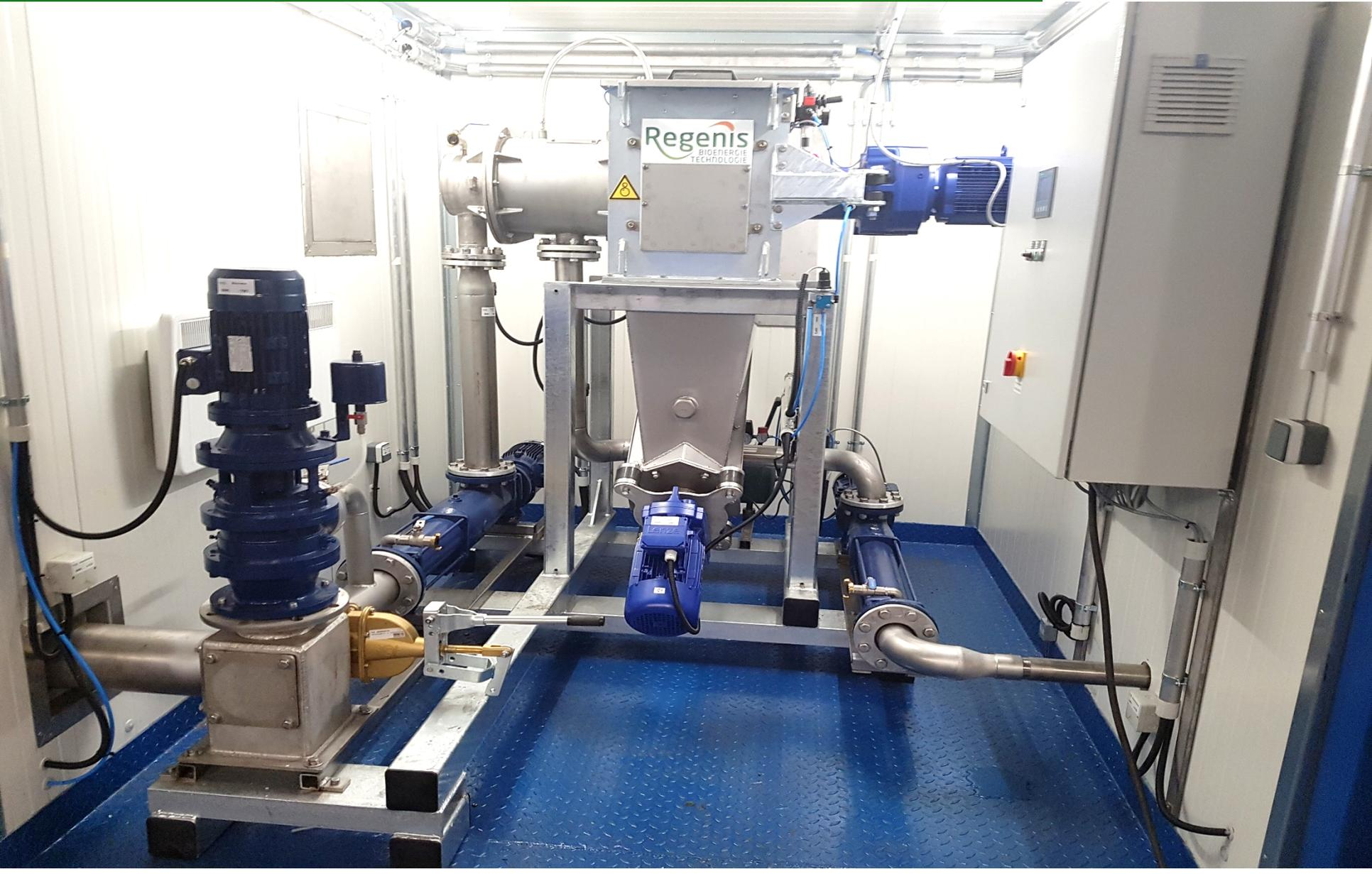
*Stationäre Regenis GE Separatoren können mit Nachfolgeverfahren vernetzt werden wie: Trocknung, Kompostierung, Strippung, Feinfiltration, FEX-BHKW usw.*
