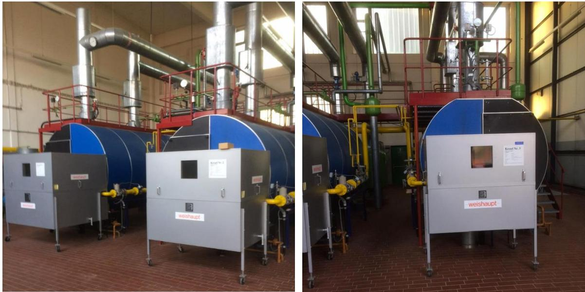
Abbildung 3 Erdgas-Gebläsebrenner der ehemaligen Bundeswehr Heizzentrale am Standort Krampe<sup>3</sup>
