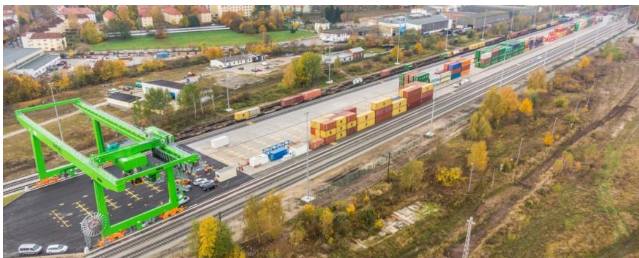
Figure 4 – Frankfurt Oder - terminal
