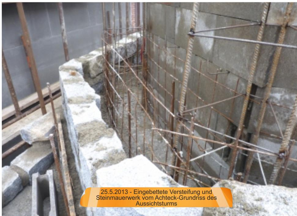
25.5.2013 - Eingebettete Versteifung und Steinmauerwerk vom Achteck-Grundriss des Aussichtsturms
