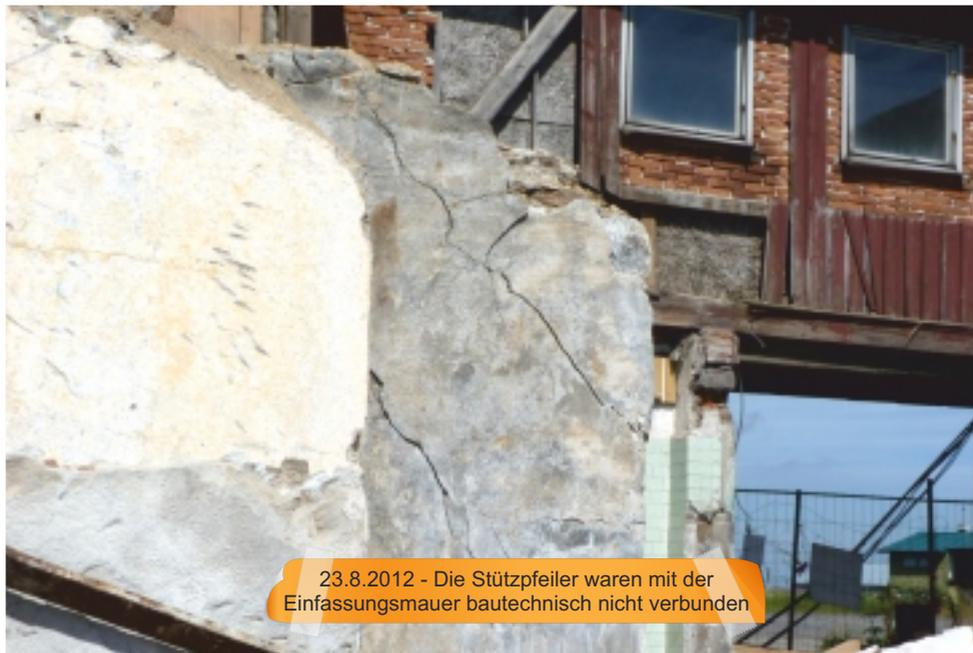
23.8.2012 - Die Stützpfiler waren mit der Einfassungsmauer bautechnisch nicht verbunden
