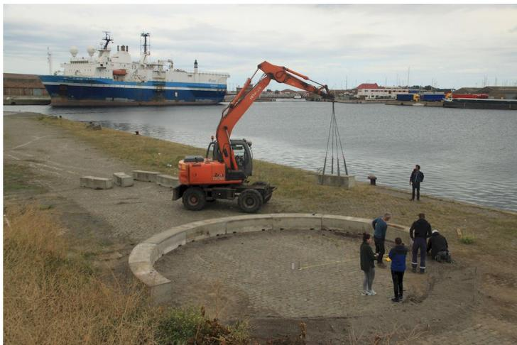
Pose des blocs de béton au bout du môle 1 pour la construction du colisée. © En Rue
