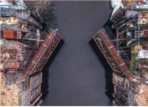
Ланкупяйский шлюз (Клайпедский район)
