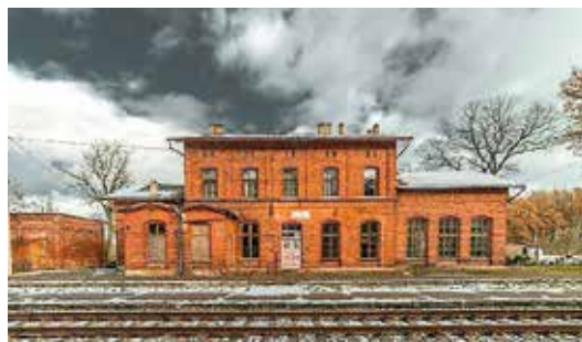
Комплекс железнодорожного вокзала в Приекуле (Клайпедский район)
