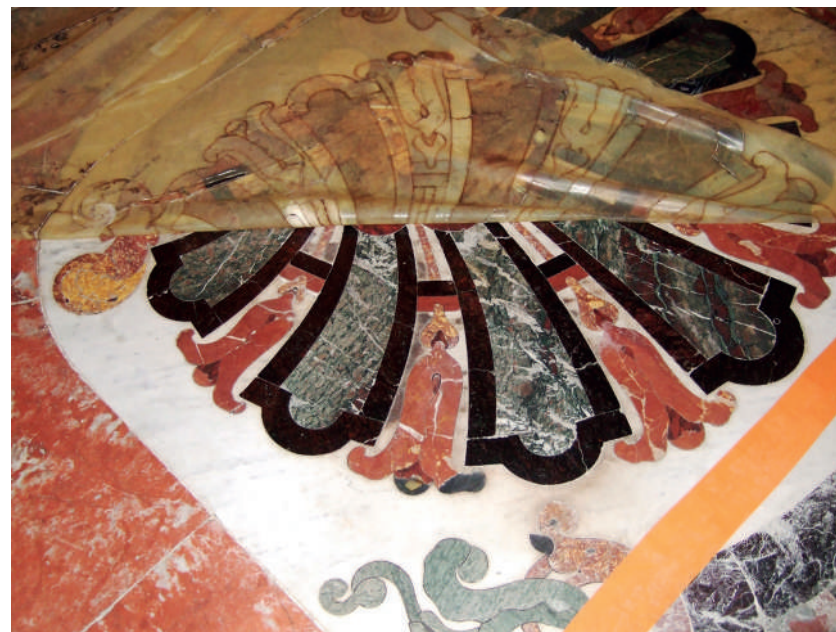
Рис. 4. Принцип действия натурального латекса Arte Mundit®
