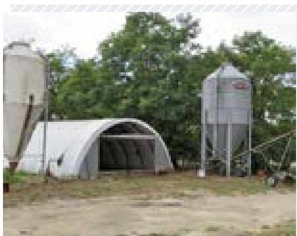
5. kép: Móricgát, fóliaborítású libaházaló épület. A mobilis (könnyen bontható, áthelyezhető) épületek és berendezések a gyors profilváltást is lehetővé teszik 8 .
