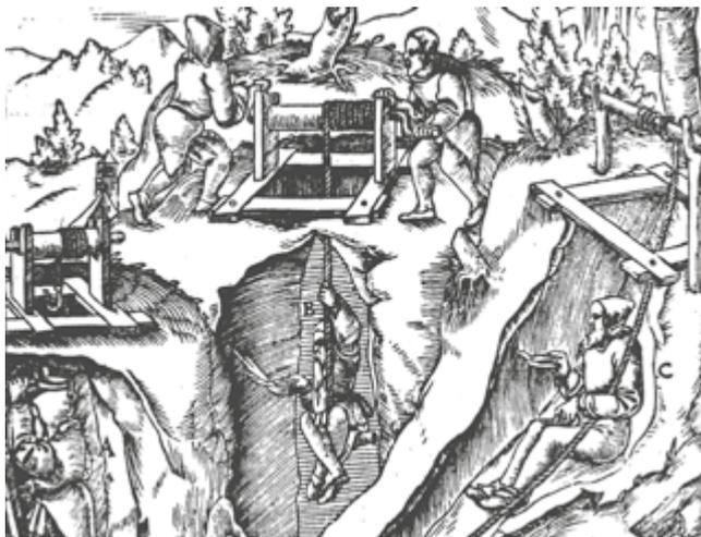
▲ Svislá a úklonná šachta / Seiger und tonnläger Schacht (podle Agricola 1556 / nach Agricola 1556)
