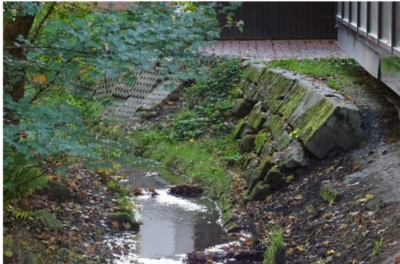
*Abbildung 2-8 Stark beschädigter Steinsatz und sogenannter „Wilder Verbau“ im Prallhangbereich eines kleinen Gewässers. Eine grundlegende Erneuerung der Uferbefestigung ist aufgrund der angrenzenden Nutzungen unumgänglich. (Bild: Garack 2017)*
