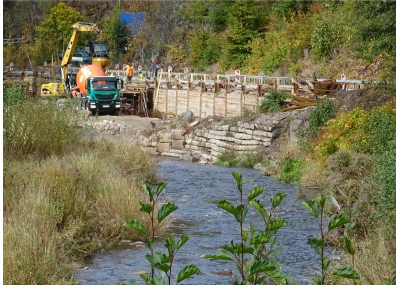
Abbildung 2-6 Die Herstellung von Ufermauern kann insbesondere aufgrund angrenzender Nutzungen kostenintensiv werden. (Bild: Garack 2018)
