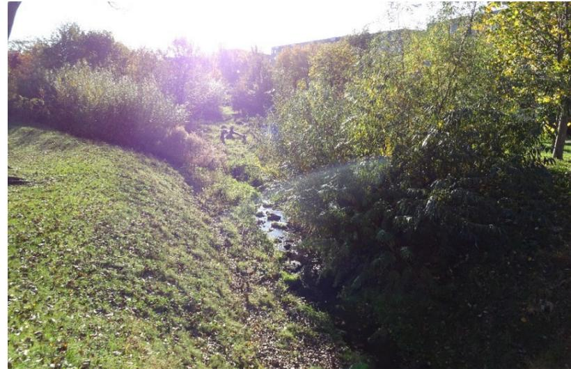
*Abbildung 2-2 Renaturierter Koitzschgraben im Stadtgebiet von Dresden. Hochwasservorsorge wurde mit Aspekten der Naherholung, Klimaanpassung und gewässerökologischer Aufwertung verbunden. Ein Best-Practice-Beispiel für die Entwicklung kleiner urbaner Fließgewässer. (Bild: Garack 2017)*
