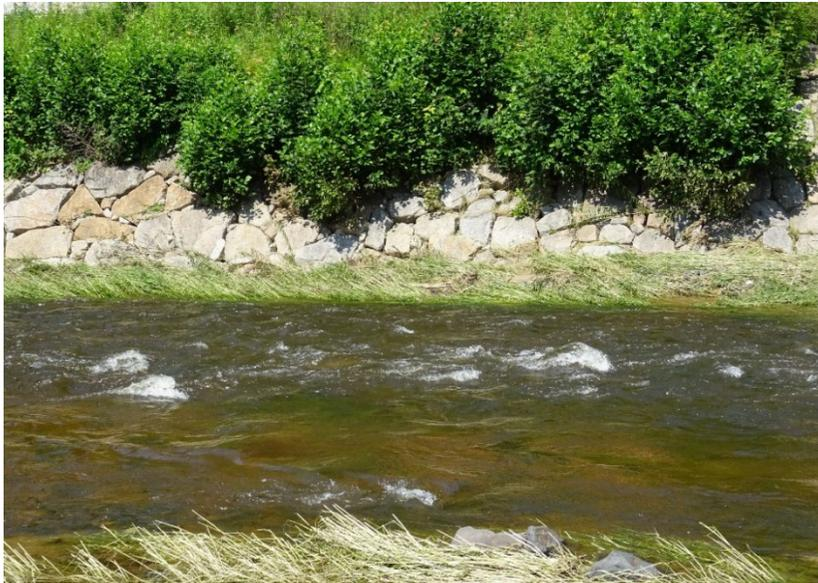
Abbildung 1-1 Begrünter Steinsatz am Gewässer Smědá in Frýdlant (CZ) – ein guter Kompromiss zwischen Widerstandsfähigkeit und Naturnähe. (Bild: Garack 2019)
