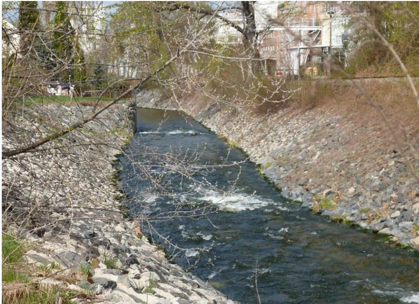
Abbildung 2-9 Einengung des Querprofils aufgrund angrenzender Nutzungen führt im Hochwasserfall zu einer besonderen hydraulischen Beanspruchung der Uferbefestigung in Fließrichtung links. (Bild: Garack 2013)
