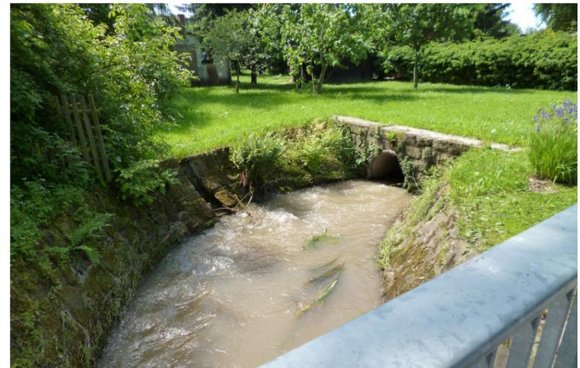
Abbildung 2-1 Hydraulisch ungünstiger Übergang vom Trapezprofil in Massivbauweise in eine Verrohrung an einem Gewässer 2. Ordnung. Bei weiter steigendem Wasserstand drohen Überspülung, Beschädigung der Uferbauweisen und Erosion im Gewässerumfeld. (Bild: Garack 2013)
