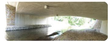
...ist das Vorhandensein von so genannten Bermen, die dem Fischotter die Unterquerung von Brücken trockenen Fußes ermöglichen, essentiell, denn viele Fischotter werden Opfer des Straßenverkehrs.
