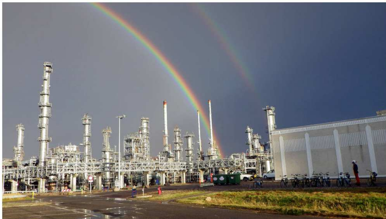
Raffineri: Statoils oljeraffineri i Kalundborg er knyttet til flere av nabobedriftene gjennom utveksling av blant annet vann og damp. (Bilde: Statoil)
