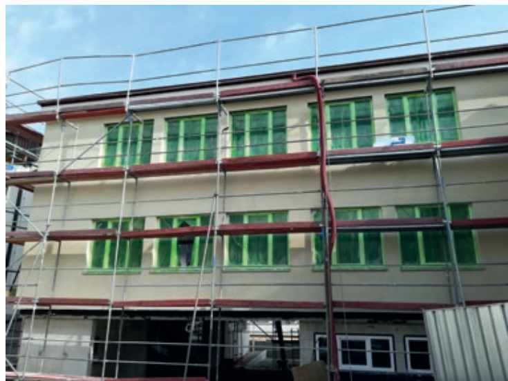
Nastajanje fasade na prizidku k OŠ Ig
