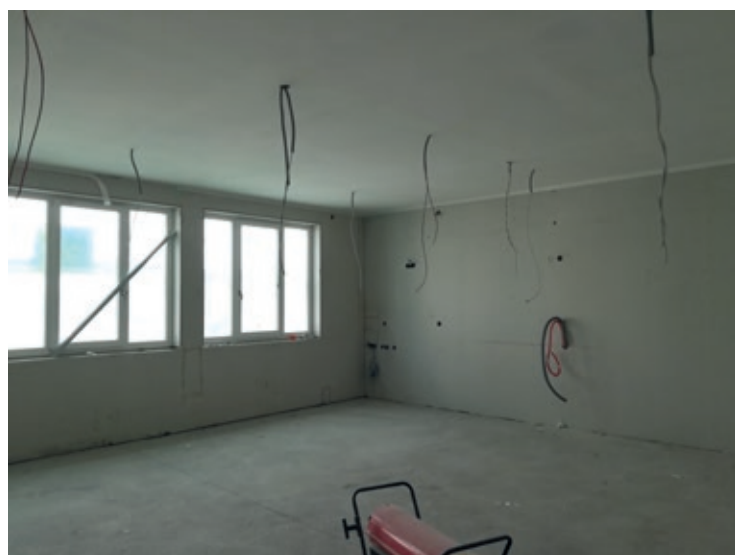
Izvajanje elektroinstalacij v eni izmed učilnic v prizidku
