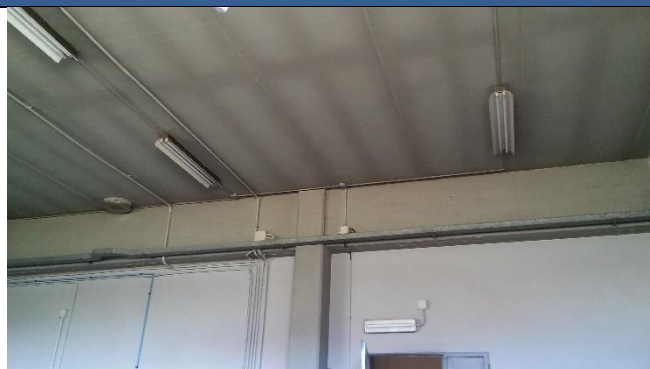
Intradosso del solaio in latero-cemento
