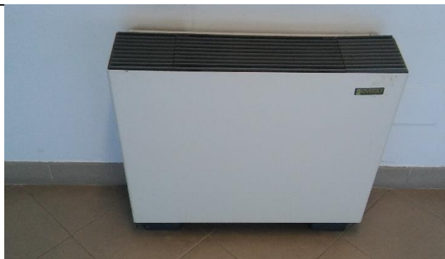
Dettaglio fancoil corridoi piano seminterrato
