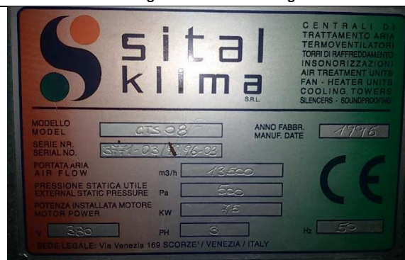
Dettaglio UTA uffici/laboratori
