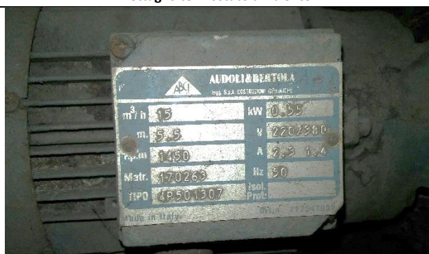
Dettaglio pompa di circolazione circuiti acqua calda sala esposizione e fancoil uffici
