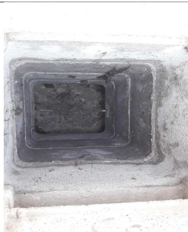
Immagine dei camini di areazione del doppio solaio
