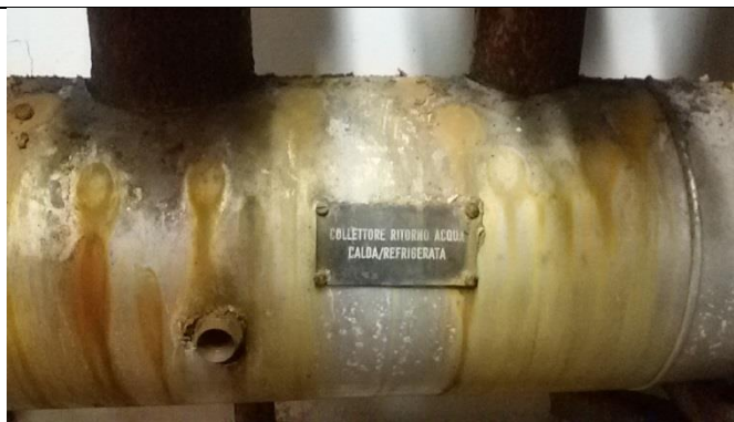
Dettaglio deterioramento collettore 1– Sottocentrale termica 2
