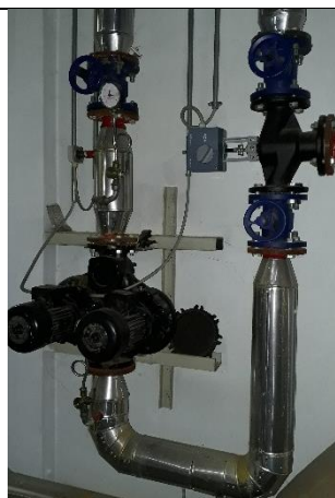
Dettaglio mandata acqua calda ventilconvettori
