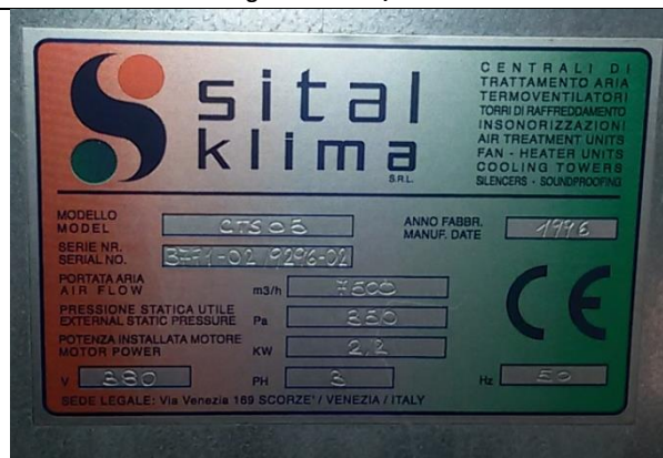
Dettaglio UTA estrazione uffici
