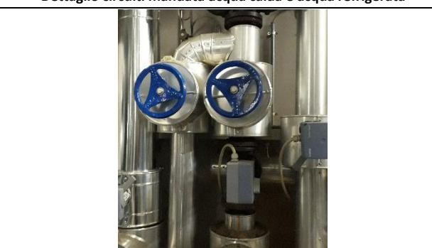
Dettaglio valvola miscelatrice circuito acqua calda ventilconvettori
