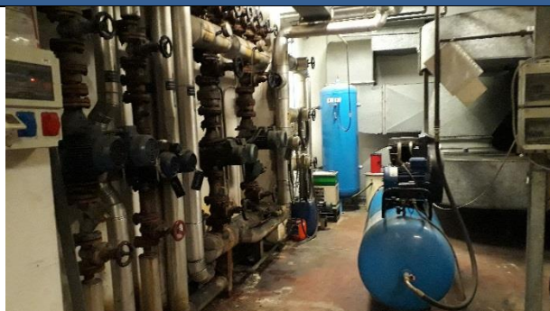
Dettaglio circuiti ventilconvettori – Sottocentrale termica "camere schermate"
