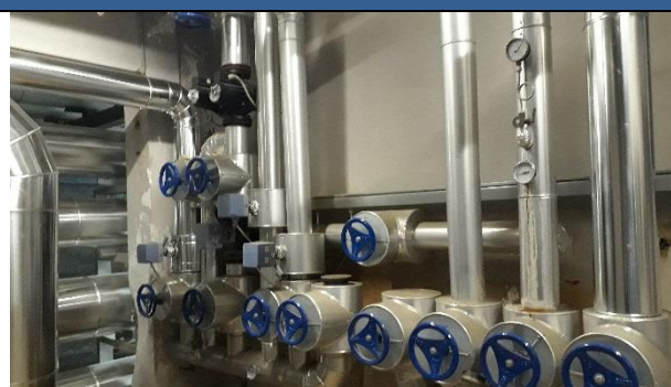
Dettaglio circuiti mandata acqua calda e acqua refrigerata
