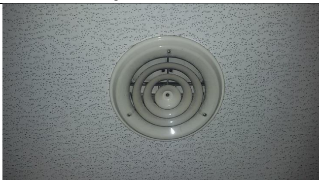
Dettaglio bocchetta estrazione aria corridoi
