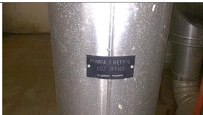
Particolare circuito mandata acqua refrigerata CDZ Uffici
