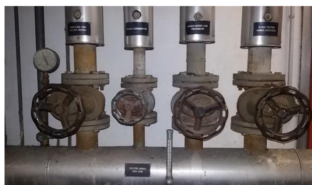
Particolare collettore mandata acqua calda– Sottocentrale termica 2
