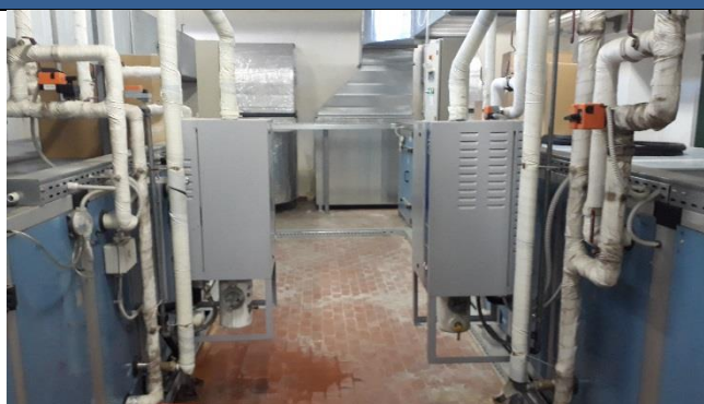
Gruppi trattamento aria lab. grande e lab piccolo - Sottostazione condizionamento lab. Edificio "A"-"B"
