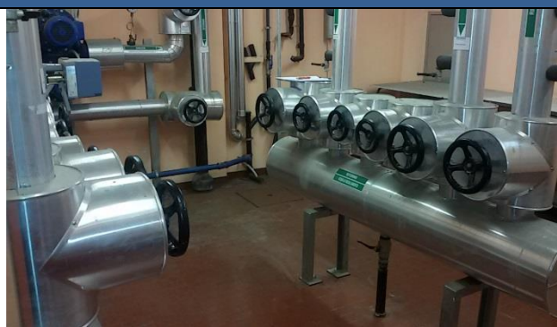
Dettaglio collettore di ritorno acqua calda
