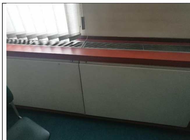
Dettaglio fancoil uffici/laboratori
