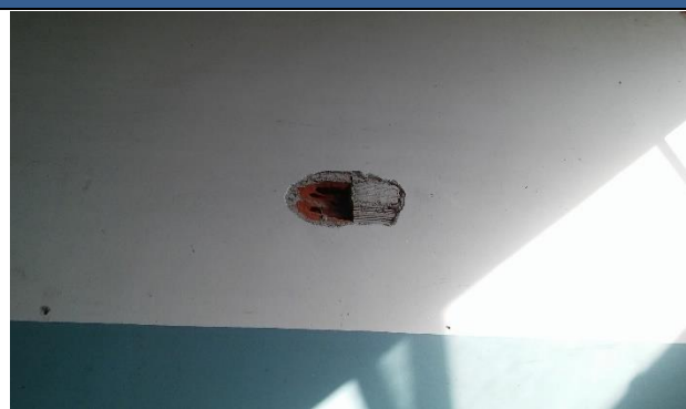
Dettaglio delle caratteristiche della muratura di tamponamento
