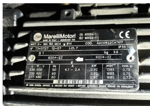
Dettaglio pompa di circolazione mandata acqua calda ventilconvettori
