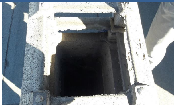
Dettaglio delle aperture di ventilazione dei solai
