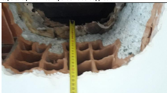
Intradosso del solaio-tipo in latero-cemento e della coibentazione
