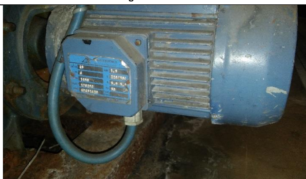
Dettaglio pompa di circolazione circuito acqua calda CDZ in copertura
