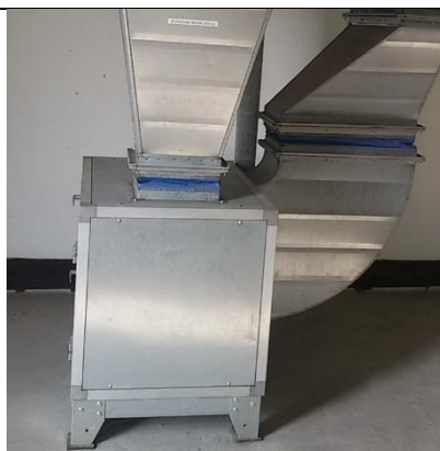
UTA estrazione bagni - Sottocentrale GTA-Copertura edificio B-Lato A
