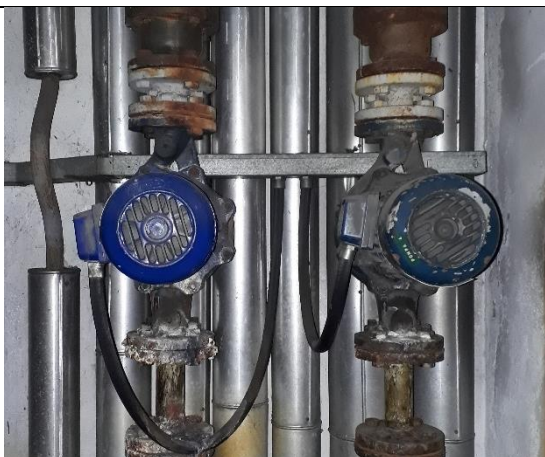
Dettaglio circuiti ventilconvettori – Sottocentrale termica "camere schermate"
