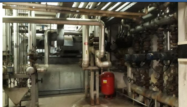
Dettaglio circuiti condizionamento – Sottocentrale termica "camere schermate"
