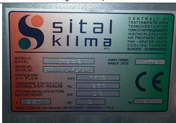
Dettaglio UTA estrazione uffici
