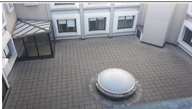
Solaio delle sala conferenza su corte interna con lucernario
