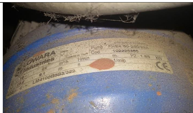
Dettaglio pompe di circolazione acqua refrigerata CDZ uffici
