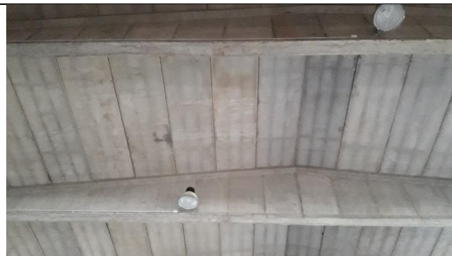
Intradosso del solaio in cemento armato
