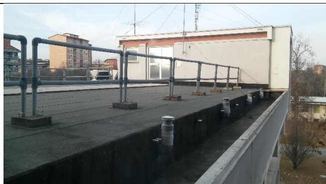
Estradosso della doppia copertura e dei camini di areazione
