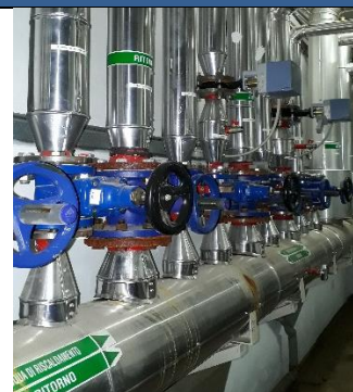
Dettaglio collettori e circuiti secondari
