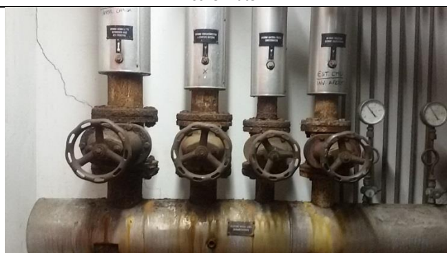
Particolare collettore ritorno acqua calda/refrigerata – Sottocentrale termica 2
