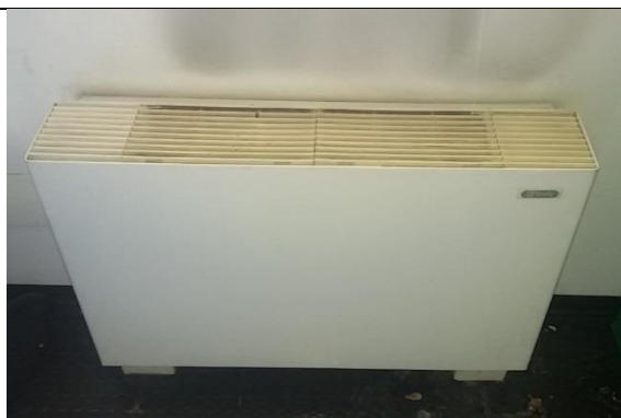
Dettaglio fancoil uffici/laboratori
