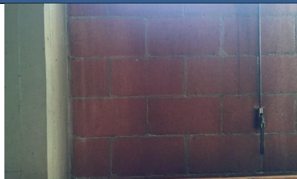
Particolare dei blocchi con coibentazione interna in argilla espansa
