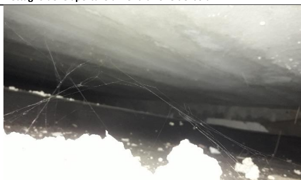
Dettaglio dell'intercapedine d'aria tra i due solai
