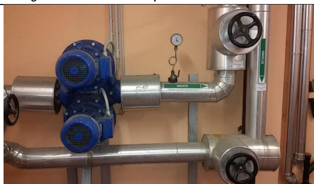
Pompa di circolazione acqua calda fancoil
