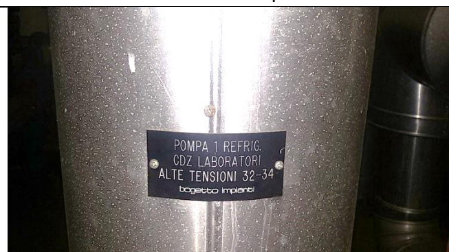
Particolare circuito mandata acqua refrigerata CDZ lab AT
