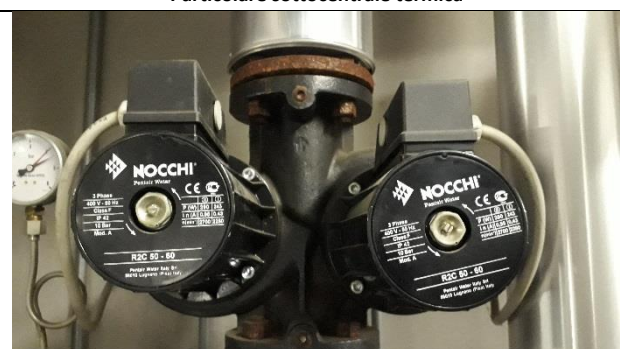
Dettaglio pompa di circolazione circuito acqua calda ventilconvettori
