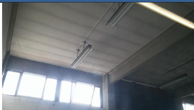
Intradosso del solaio in latero-cemento
