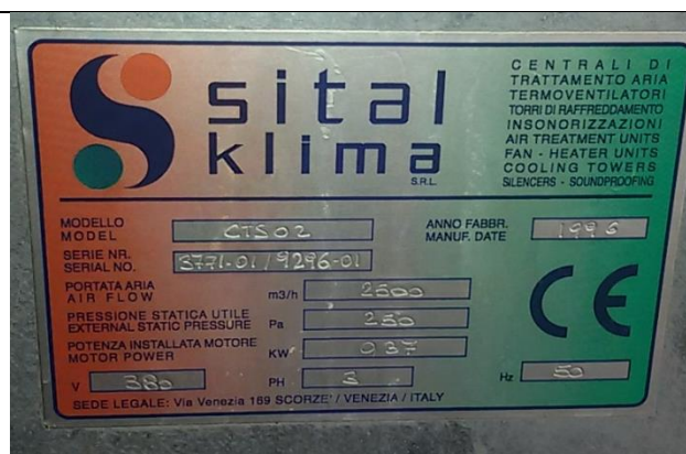
Dettaglio UTA estrazione bagni
