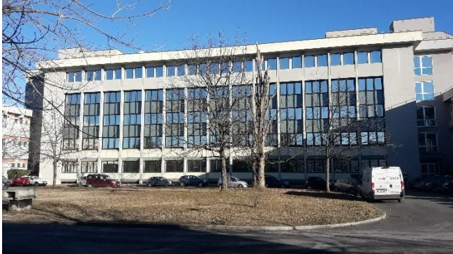
Facciata dell'edificio sul lato sud
