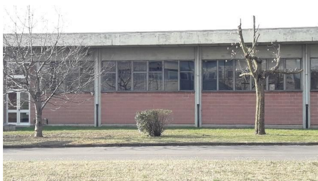
Facciata dell'edificio sul lato nord
