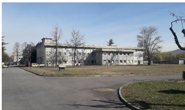
Facciata dell'edificio sul lato sud
