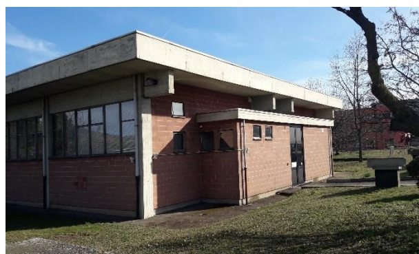
Intersezione tra le facciate nord ed ovest
