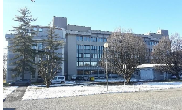
Facciata dell'edificio sul lato nord
