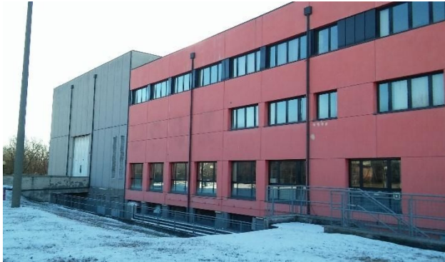
Facciata dell'edificio sul lato nord
