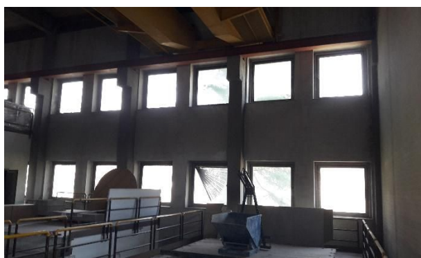
Vista interna della facciata
