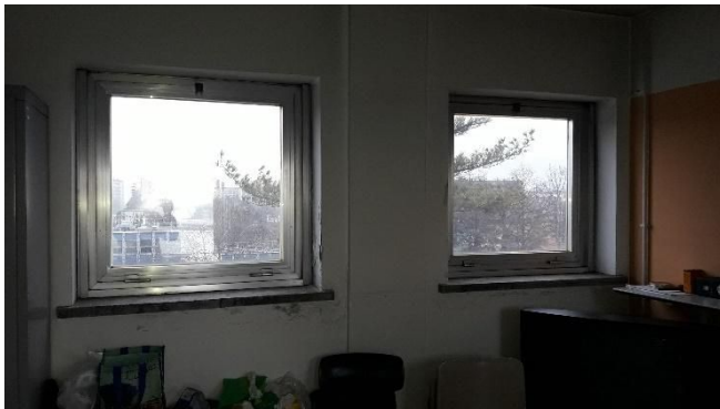
Dettaglio delle aperture modulari presenti
