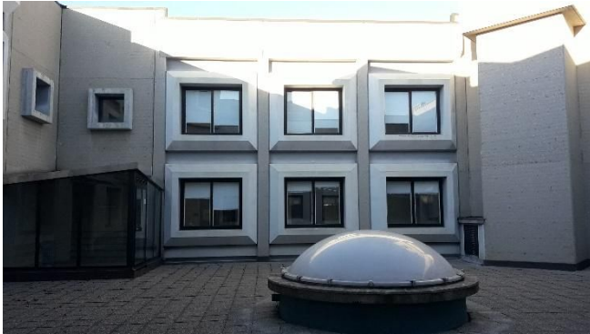
Superfici disperdenti su corte interna e dettaglio del lucernario
